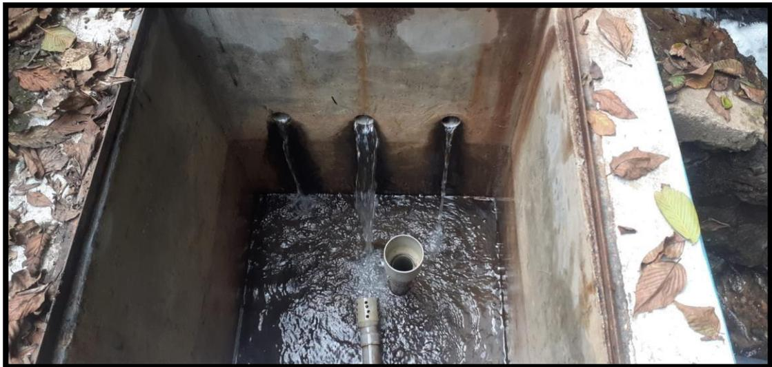
**Imagen 02:** Vista de los orificios y el cono de rebose, canastilla de salida ubicada en la cámara húmeda.
