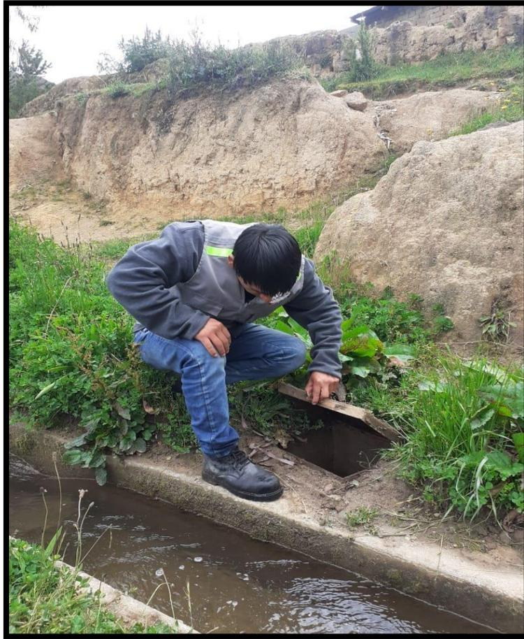
**Imagen 06:** inspección en la cámara rompe presión tipo 6, se encuentra en mal estado
