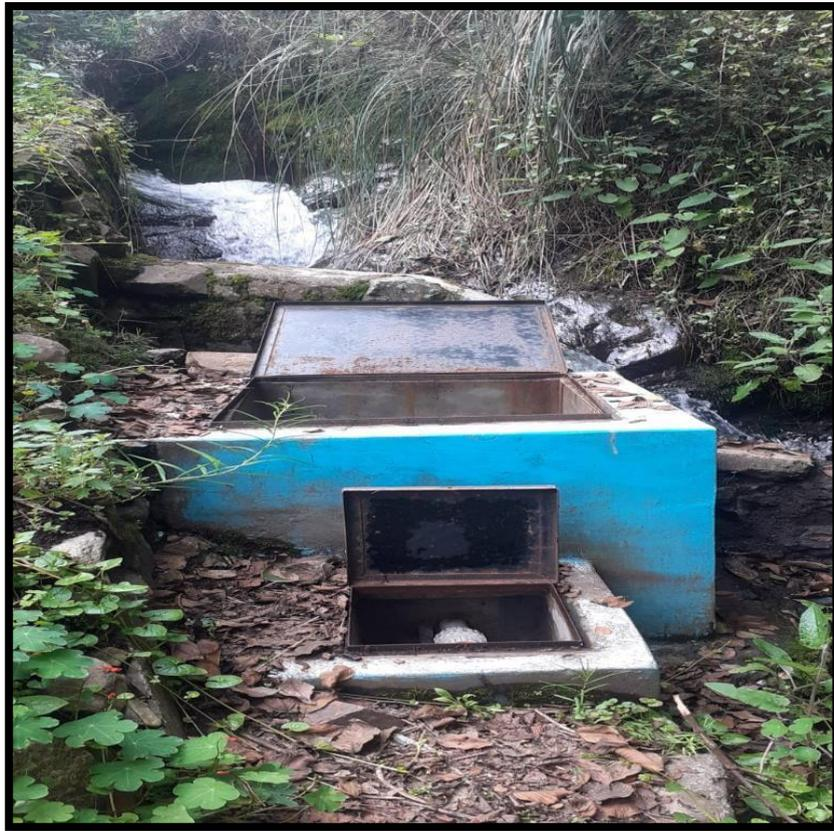
**Imagen 01:** Vista de la cámara de captación sin cerco perimétrico, ni seguros en las tapas sanitarias
