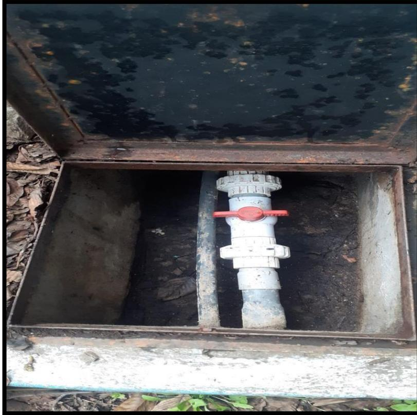
**Imagen 03:** Vista de la cámara seca la tubería de salida y la llave de paso se observa que la tapa sanitaria no tiene seguro y está en mal estado
