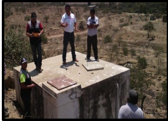
Imagen 7 : Reservorio apoyado rectangular. Fuente: Ceint Perú
