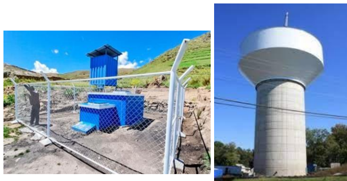
Figura 9. Tipos de reservorios Apoyado y Elevado.
