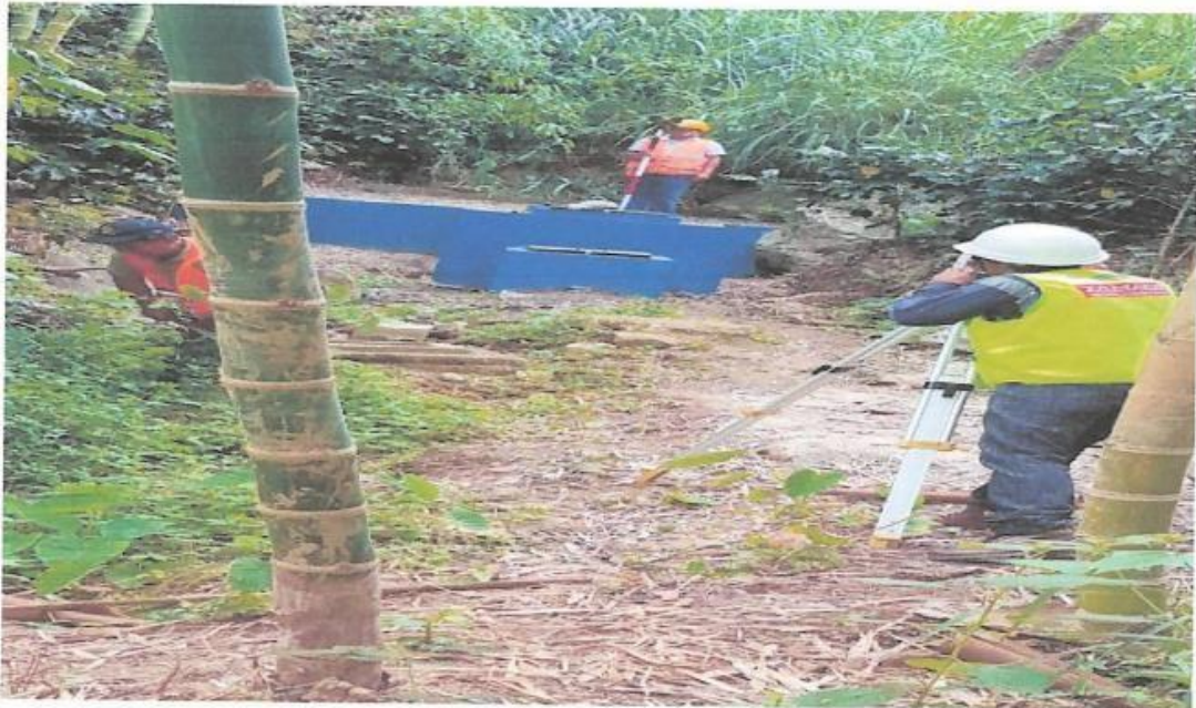
Figura N° 12 Captación Natividad del caserío de Cilia, como podrán apreciar se encuentran en buenas condiciones estructurales, pero requiere un mejoramiento de filtro y cerco de protección
