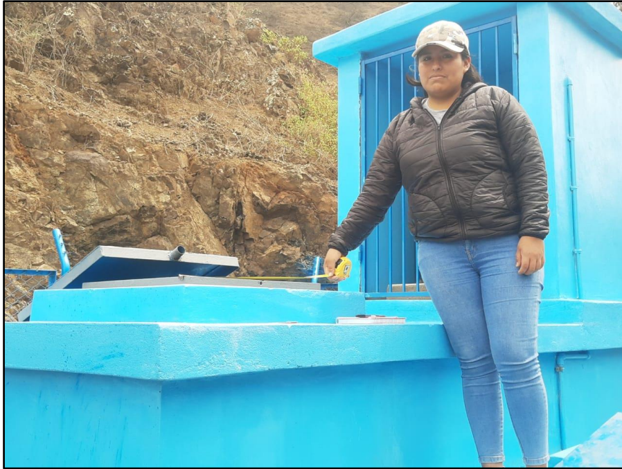
Fotografía N° 03: Midiendo las tapas sanitarias del reservorio de San Damián Fuente: Elaboración propia
