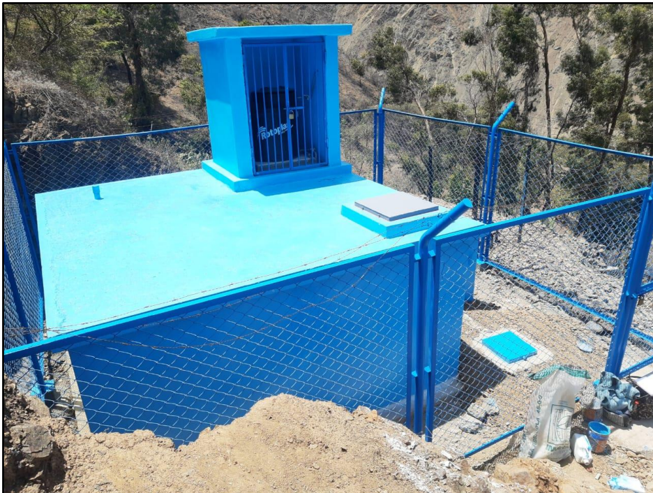
Fotografía N° 04: Reservorio de agua potable de San Damián Fuente: Elaboración propia
