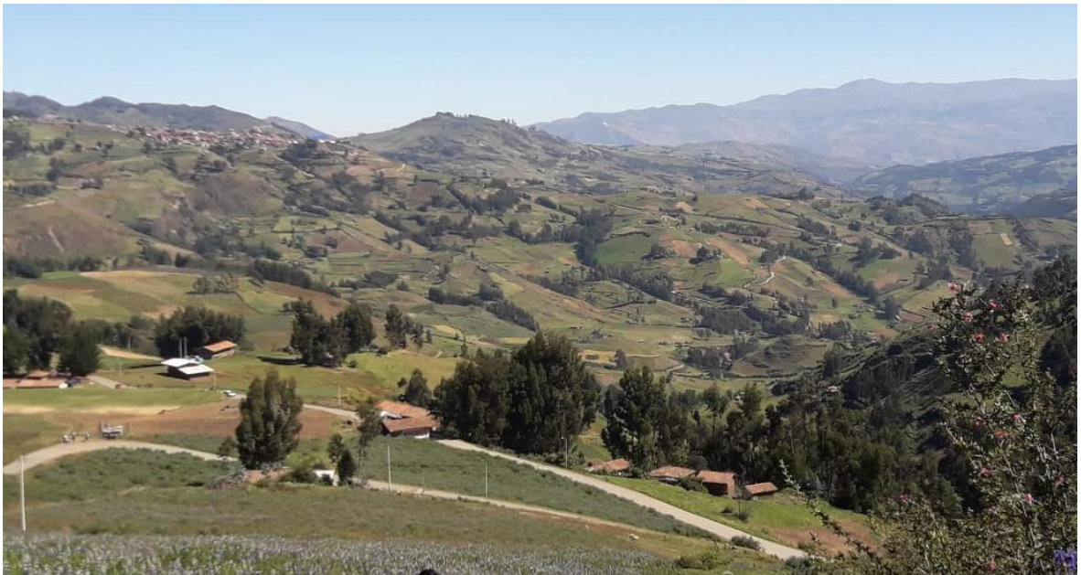
Figura 19. Vista panorámica del recorrido de la línea de conducción del centro poblado Carrapalday Chico Fuente: elaboración propia (2018)
