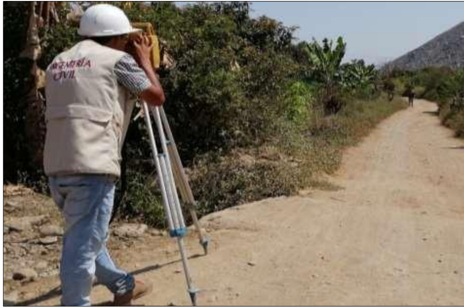
Figura 8. Levantamiento topográfico del sistema de abastecimiento de agua potable del caserío de Yapacayan
