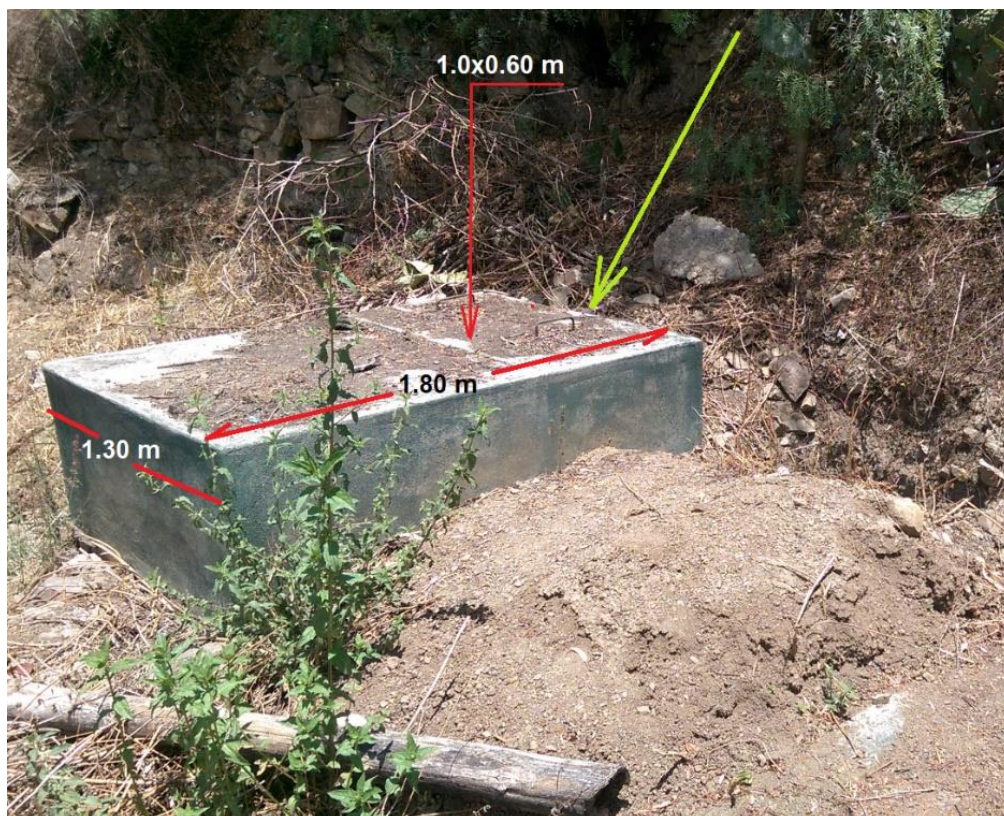
Imagen 13. Características físicas de la cámara de almacenamiento primario
