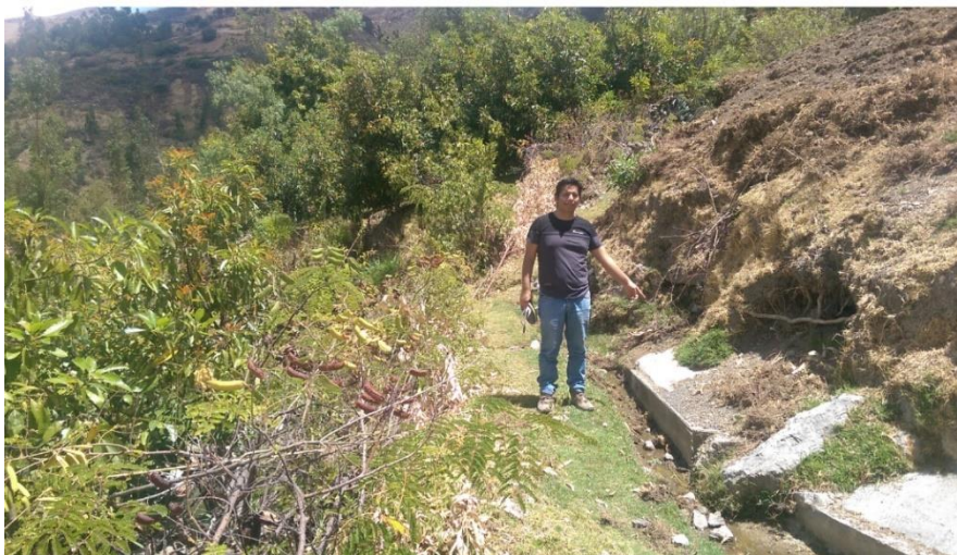
Imagen 05. Se aprecia Captación 02, creado de manera artesanal
