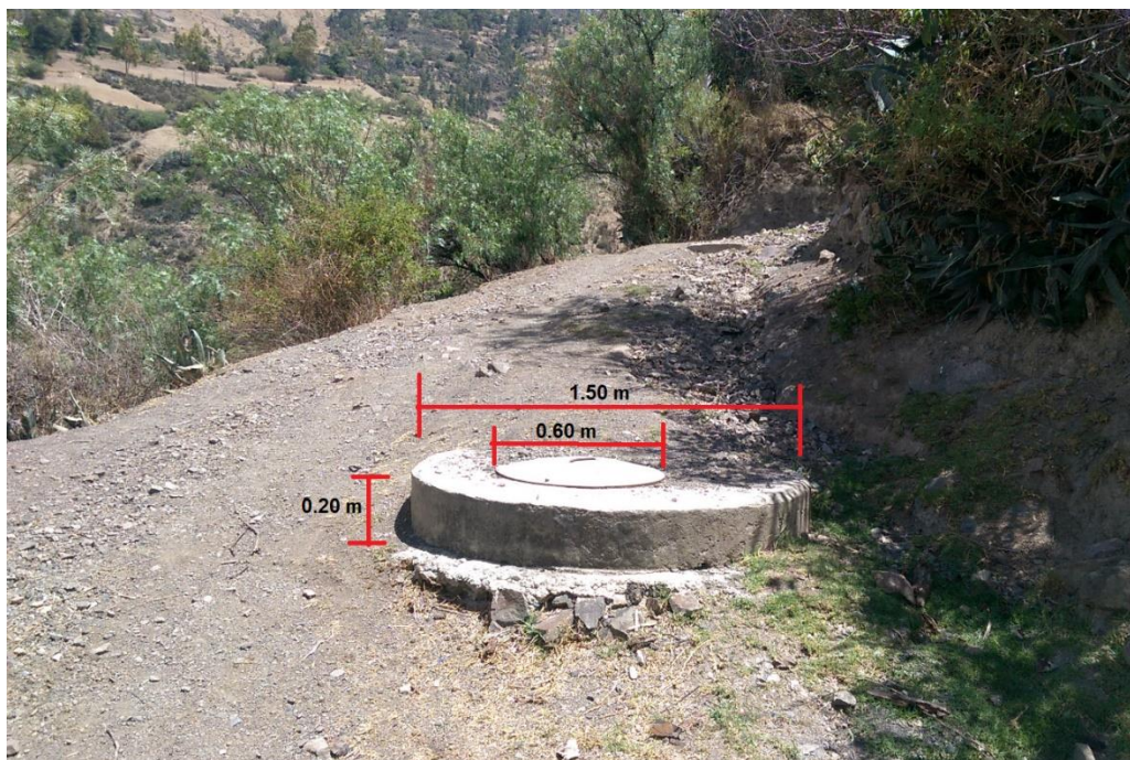
Imagen 11. Características físicas del Buzon, ubicado en las coordenadas E: 209406.00 m E; N: 8971255.00 m a una altitud de 2772 m.s.n.m.
