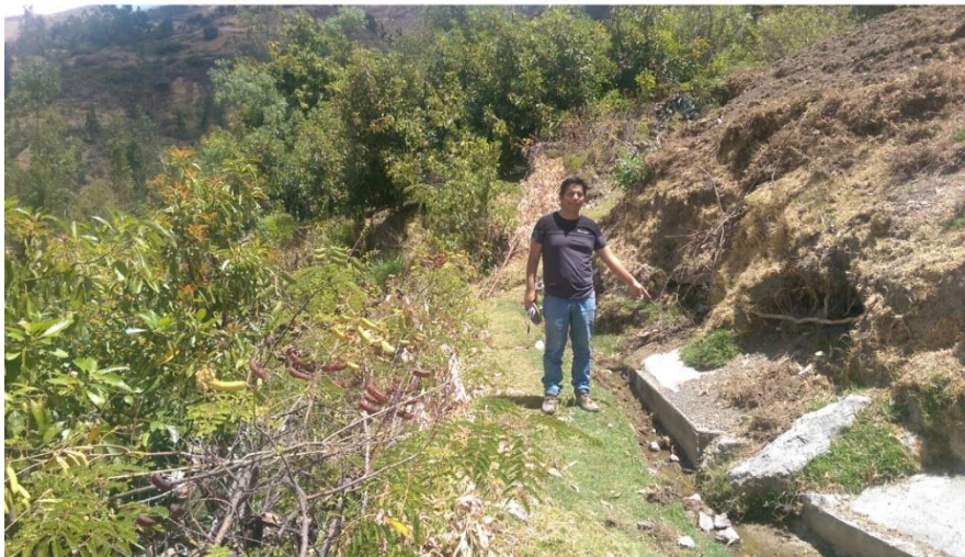
Imagen 05. Se aprecia Captación 02, creado de manera artesanal
