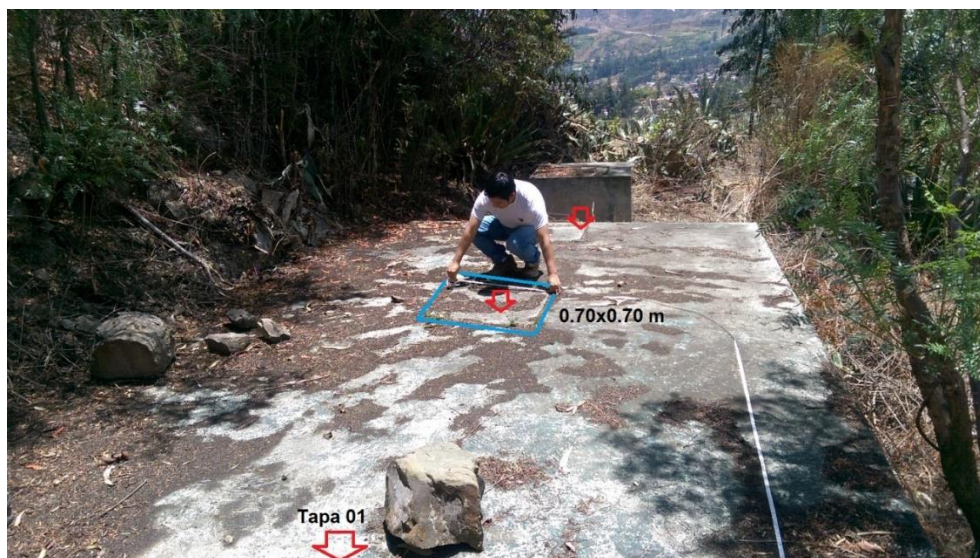
Imagen 16. Realizando el dimensionamiento de tapas sanitarias del tanque séptico
