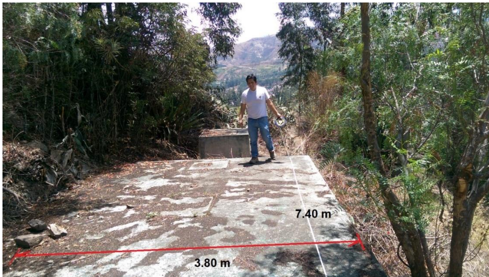
Imagen 15. Características físicas de tanque séptico
