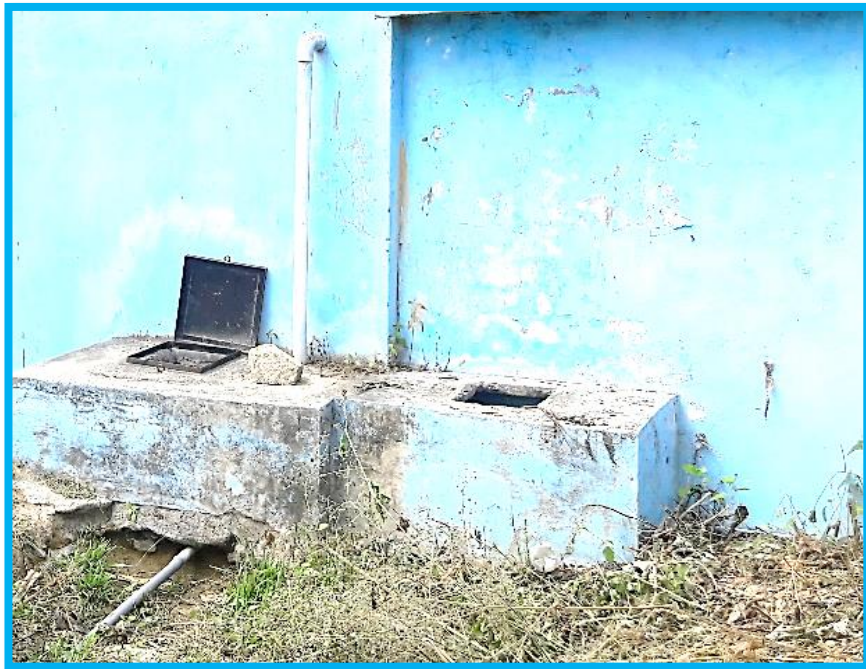
Figura 21. Reservorio del caserío San Felix
