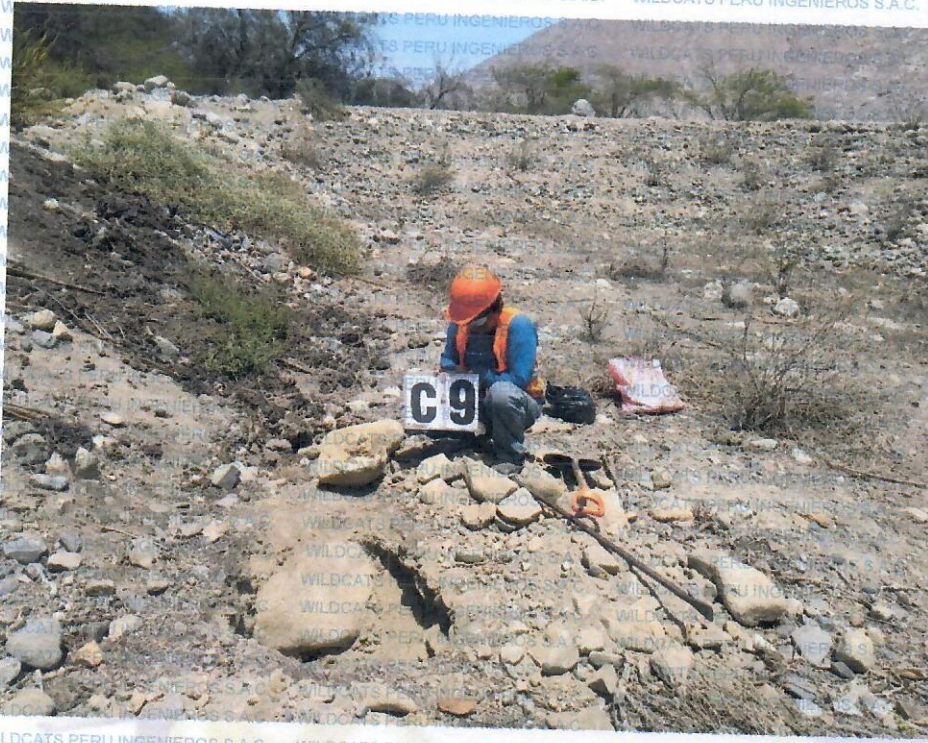
Vista panorámica de la calicata C - 9
