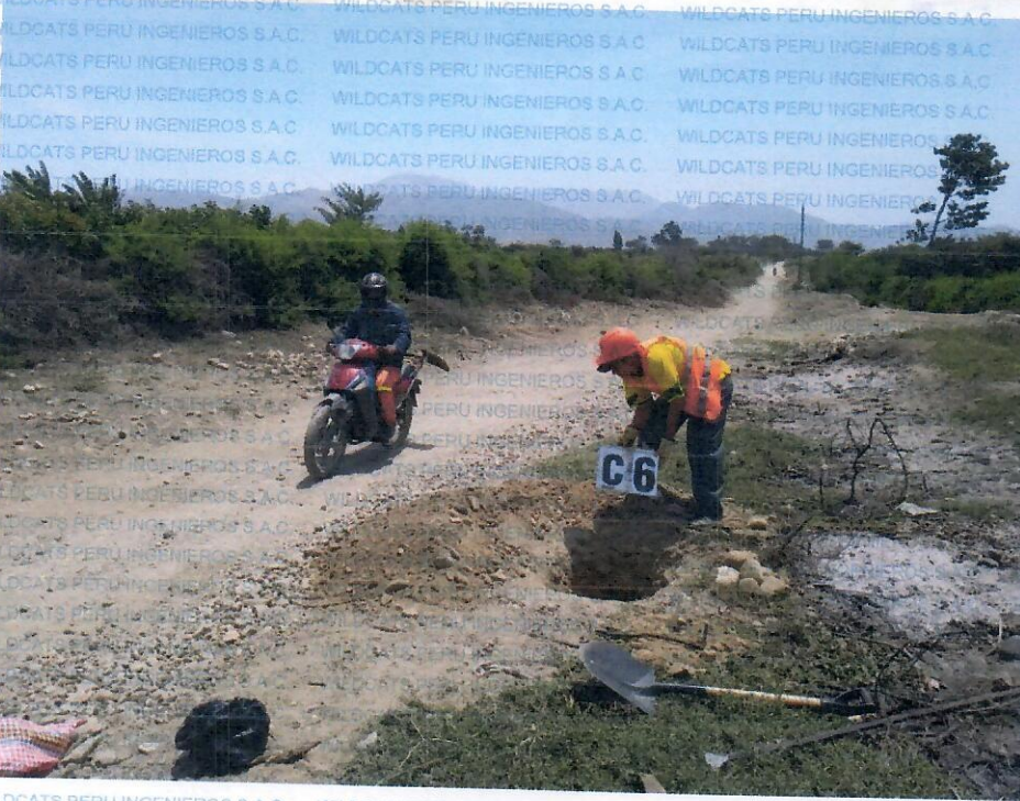
Vista panorámica de la calicata C - 6
