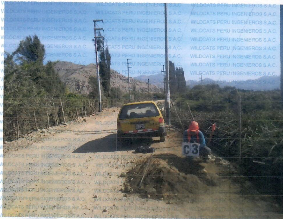
Vista panorámica de la calicata C - 3
