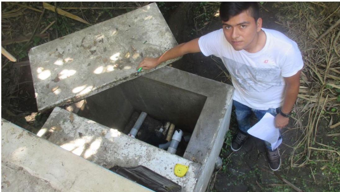
Fotografía 04: caseta de válvulas del reservorio de almacenamiento de agua potable
