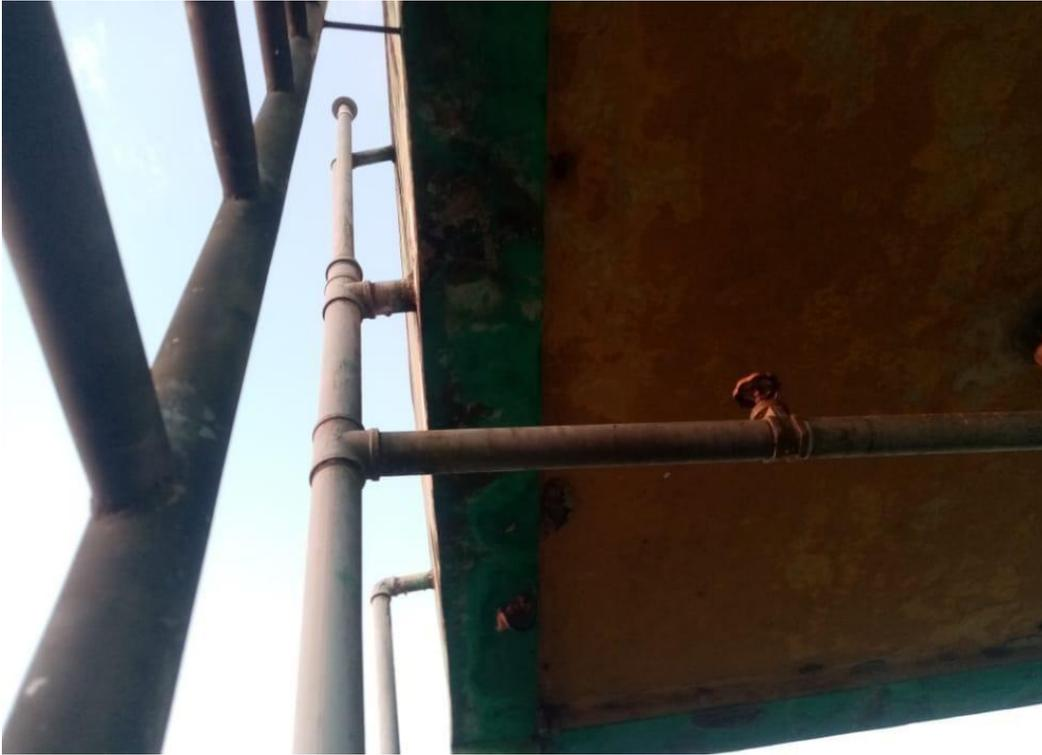
Fotografía 10: Se visualiza las conexiones de las tuberías tanto como aducción y conducción en el reservorio
