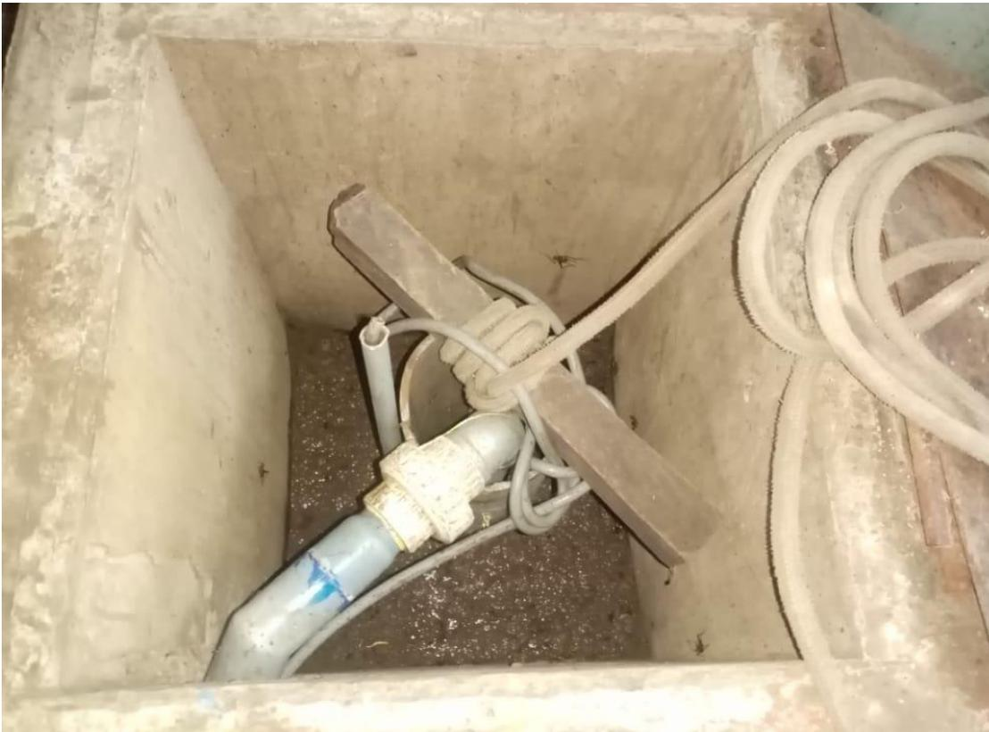
Fotografía 3: En la fotografía se visualiza el poso tubular de donde se capta el agua.
