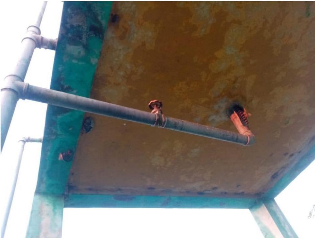
Fotografía 11: Tubería de salida del reservorio y válvula de regulación.
