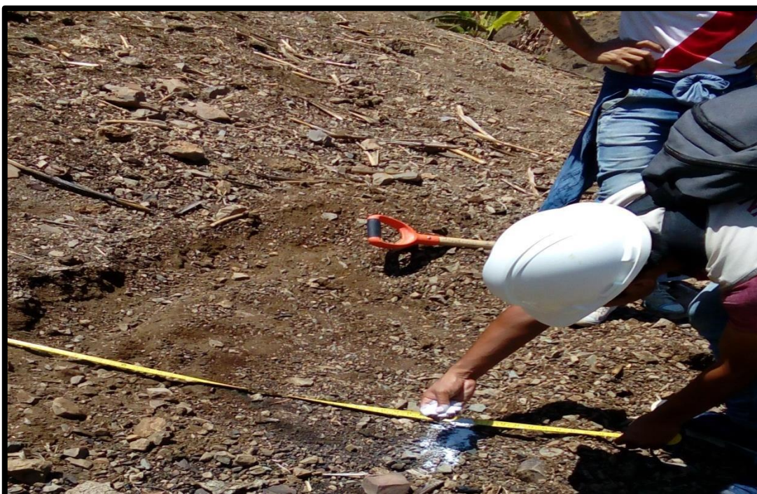
Figura 19: Trazo de la calicata 02 en el reservorio del caserío Huanchuy sector A
