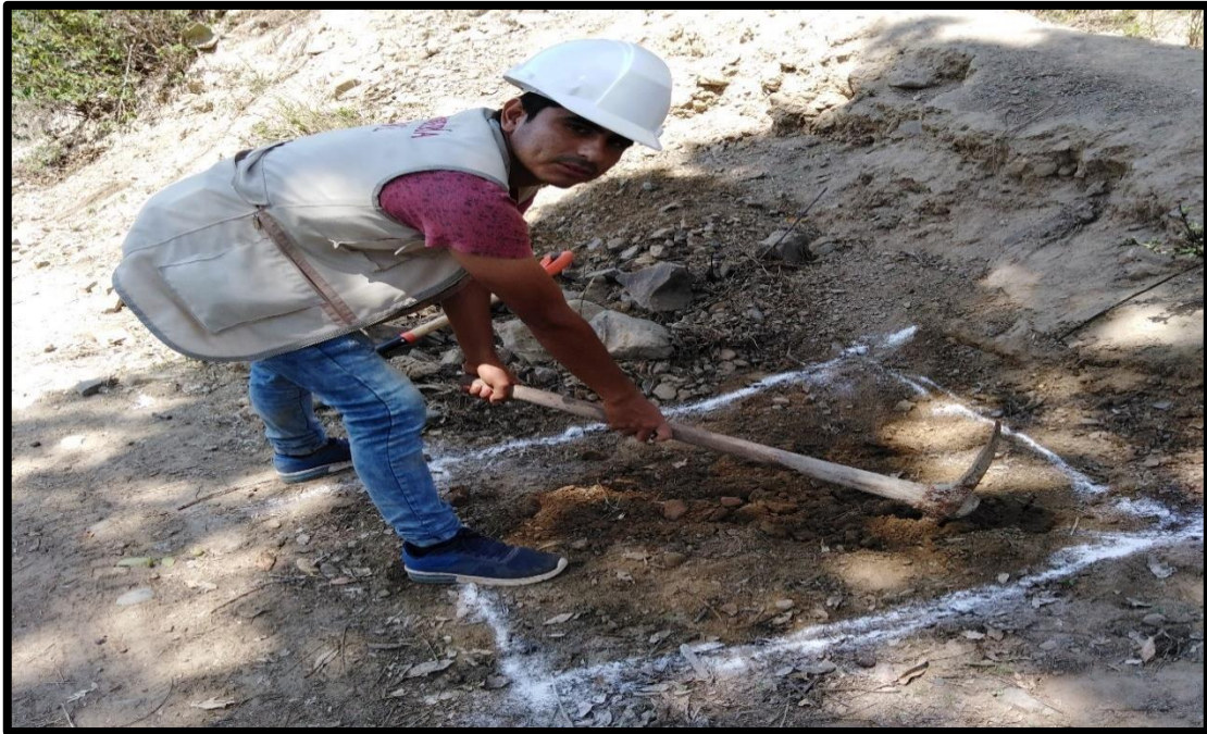
Figura 22: Trazo y excavación de la calicata 03 en el caserío de Huanchuy sector A
