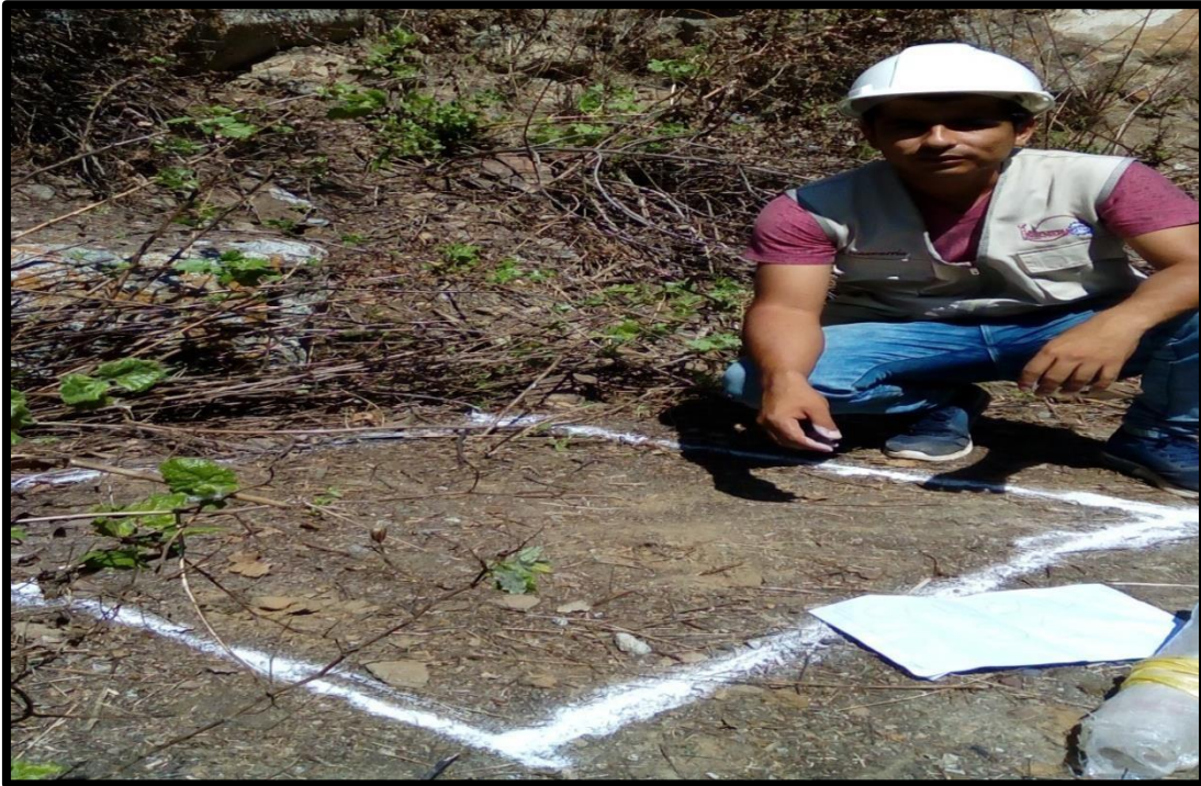
Figura 16: Calicata 01 al costado de la cámara de captación existente en el caserío Huanchuy sector A
