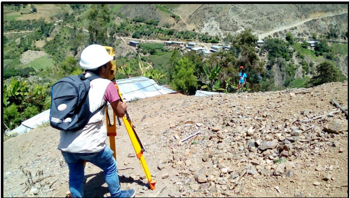
Figura 15: Levantamiento topográfico para la red de distribución
