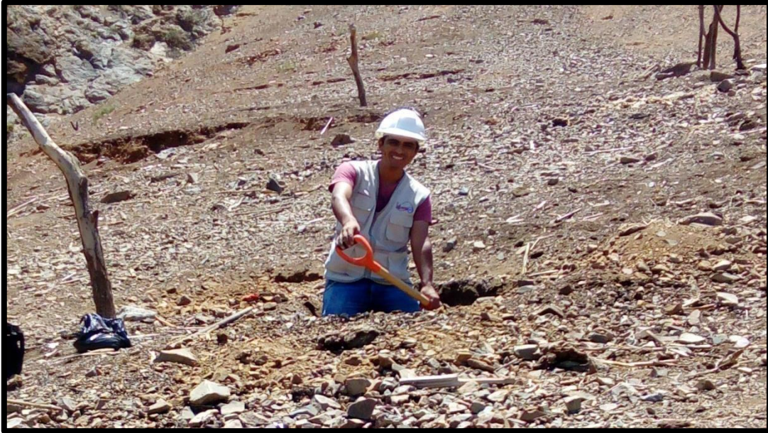
Figura 20: Excavación de la calicata 02 del reservorio
