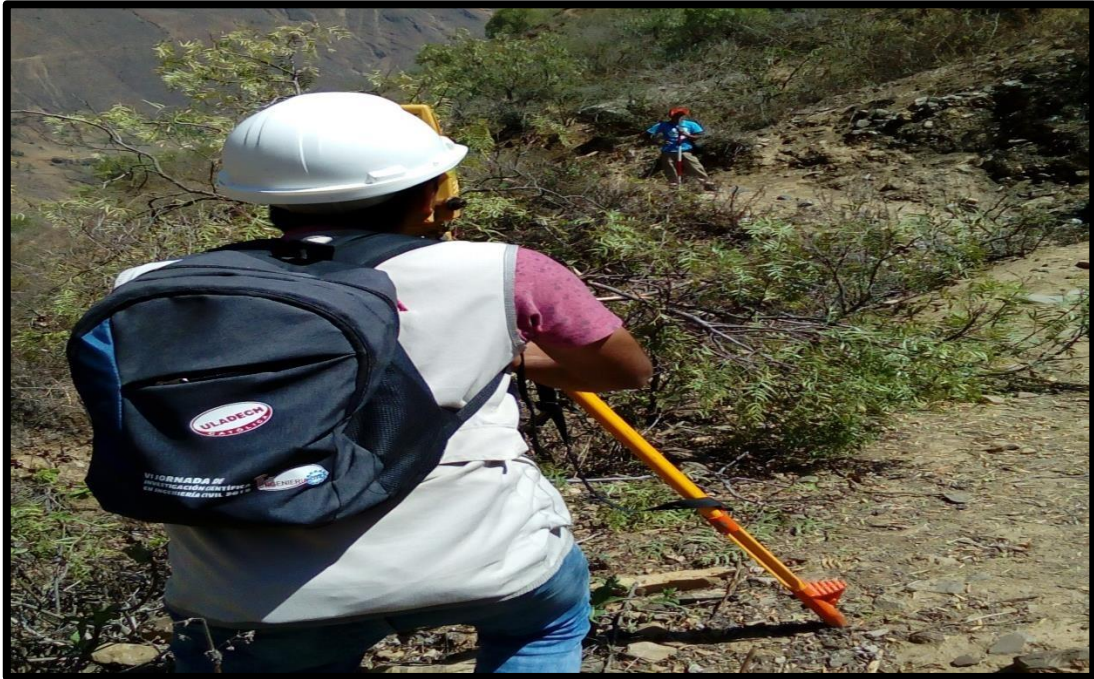
Figura 14: Levantamiento topográfico en el trayecto hacia el reservorio
