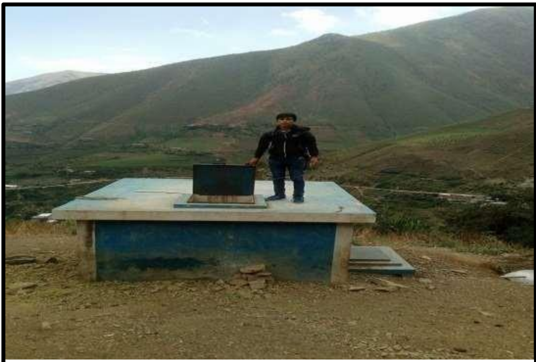
Figura 11: Reservorio de almacenamiento del caserío de Huanchuy sector A
