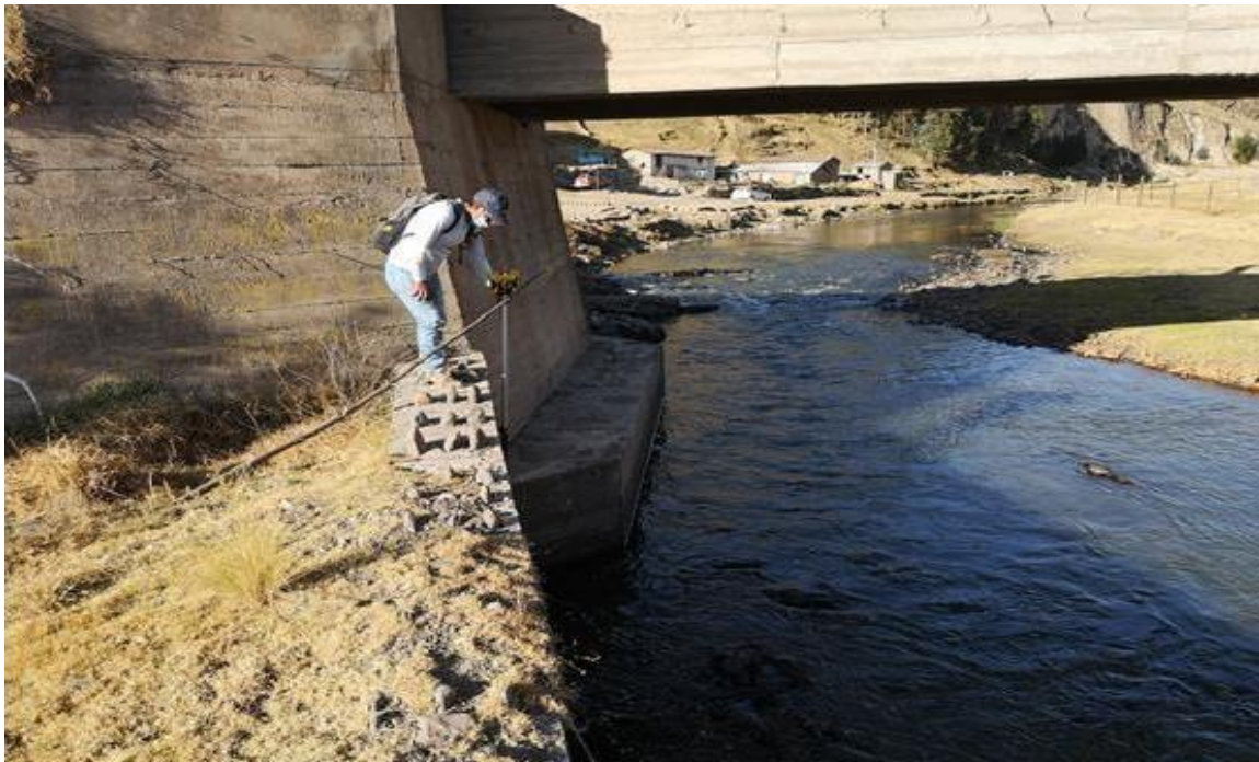
Gráfico 5. Levantamiento de puntos en muro existente
