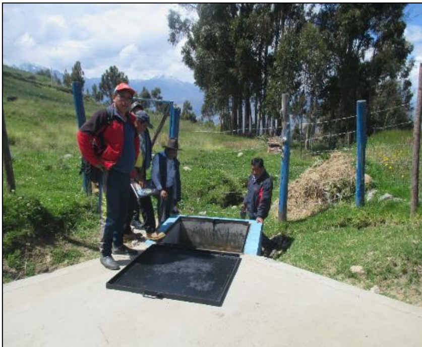
Foto N°2. Vista de la captación Cachipucro, nótese la presencia de las Autoridades.
