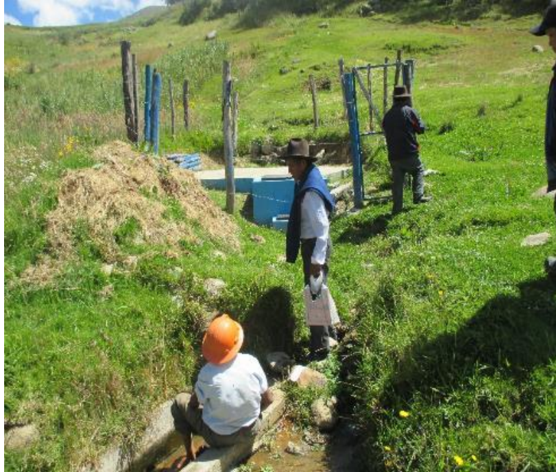
Foto N°1. Vista de la captación Cachipucro, nótese el estado del Cerco Perimétrico.
