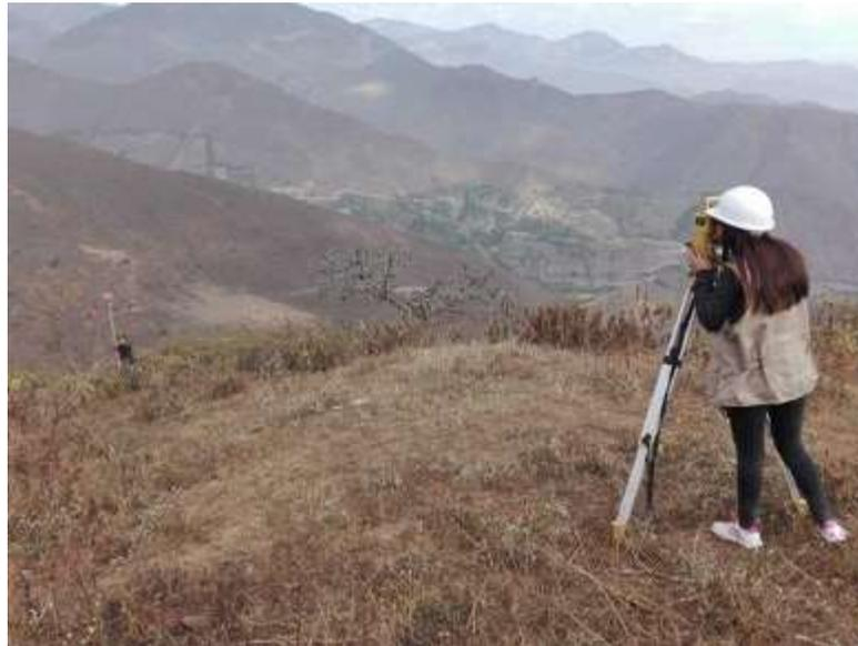
Descripción: Se realizó el levantamiento topográfico desde la captación hasta el reservorio mediante la línea de conducción del anexo Auyacoto.
