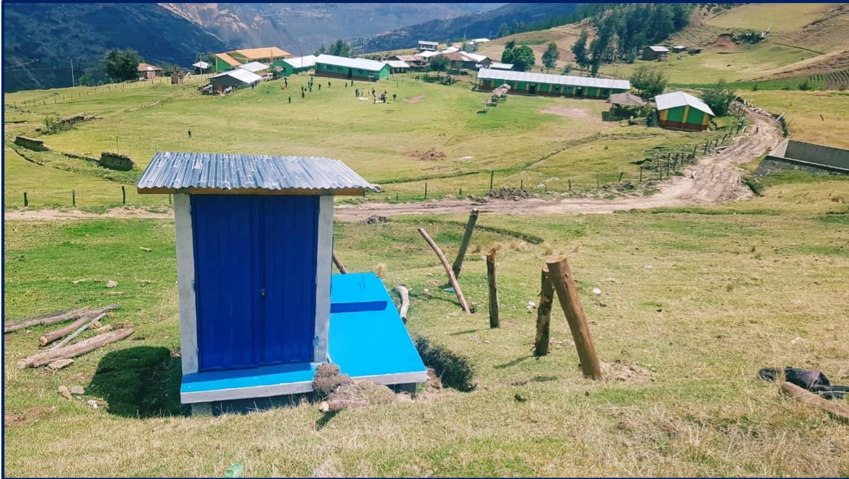
Fotografía 4: El reservorio del caserío de Yachapa, distrito de San Juan, provincia de Sihuas, región Ancash – 2019.
