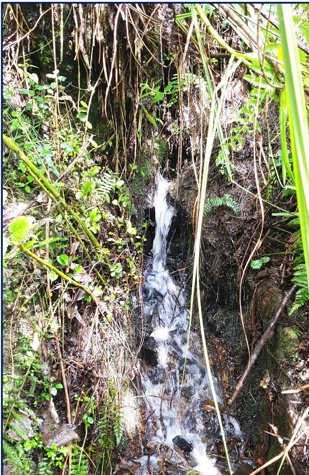
Fotografía 2: Filtración del manantial Chaupalliso, del caserío de Yachapa, distrito de San Juan, provincia de Sihuas, región Ancash – 2019.
