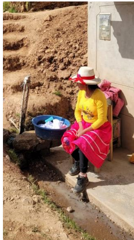
Imagen 14: Vista de la conexión domiciliar expuesta al aire libre.
