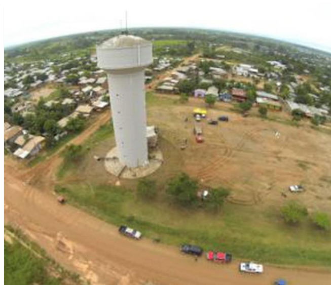
Figura 22. Reservorio elevado Fuente: Gestión
