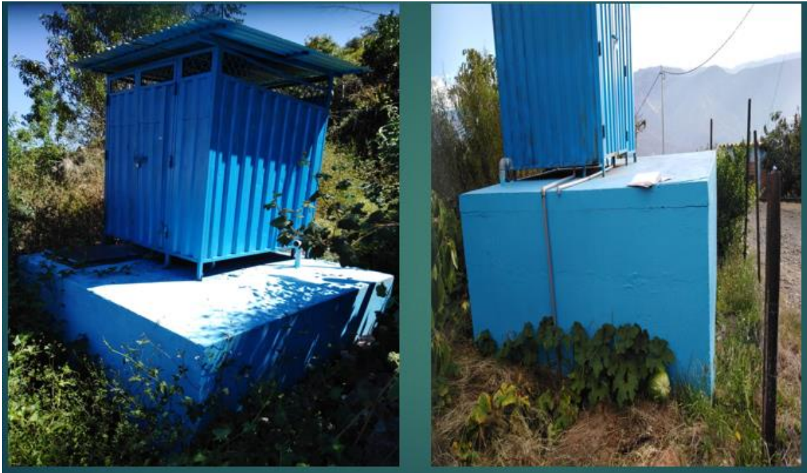
Fotografía N° 02. Foto del reservorio N°1 y N° 2 de Montebello
