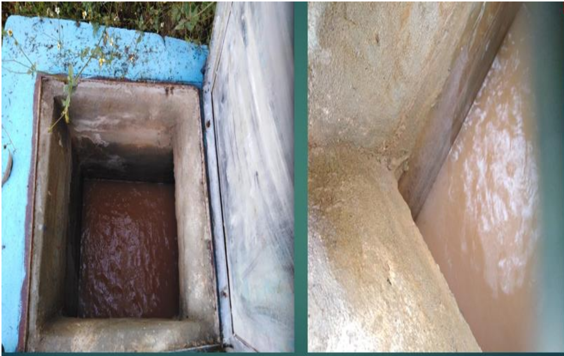
Fotografía N° 07. Captación y reservorio por dentro
