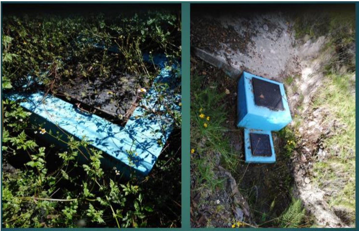
Fotografía N° 04. Captación N° 1 y N°2
