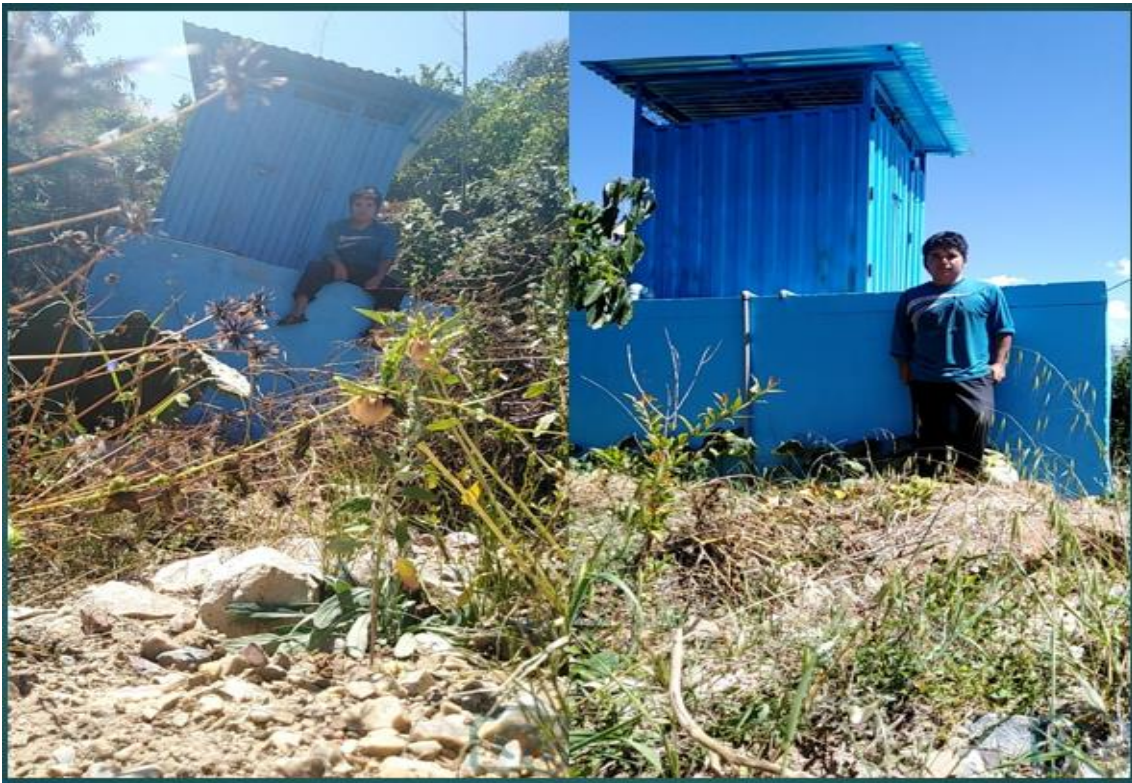
Fotografía N° 03. Foto del reservorio N°1 y N° 2 de Montebello
