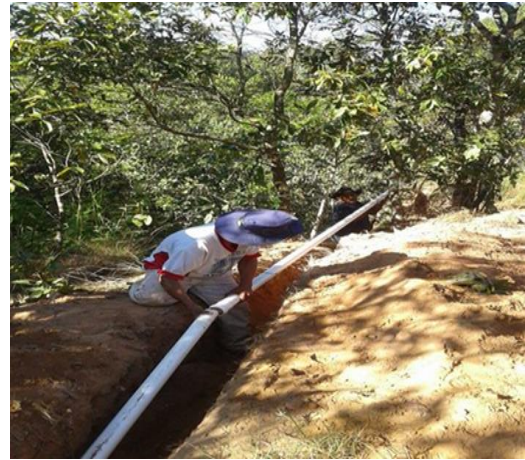
Figura 26: Mantenimiento de línea de conducción
