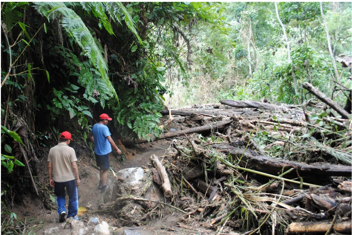
Figura 25:observación línea de conducción.
