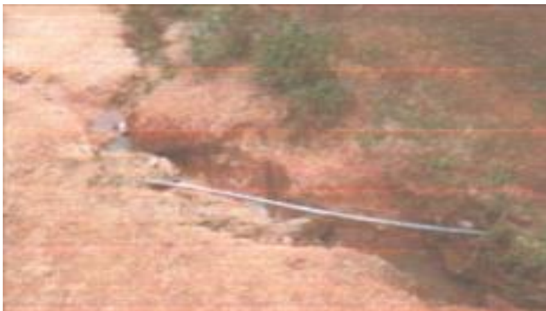
Figura 16: Línea de aducción
