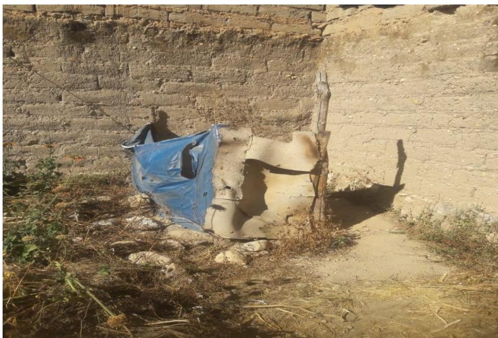
Fotografía 09: Verificación del estado actual de letrinas que se encuentran colapsadas con excretas.
