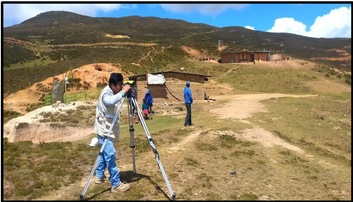
Fotografía N° 04 Realizando el levantamiento topográfico
