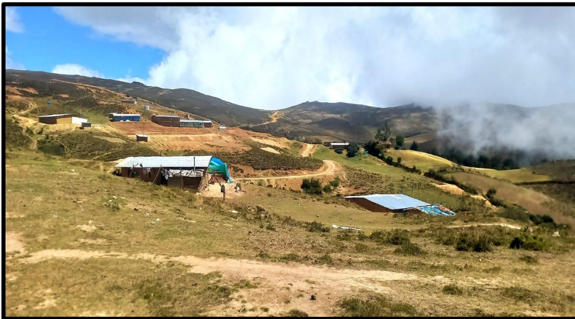
Fotografía N° 01 Centro Poblado San Luis
