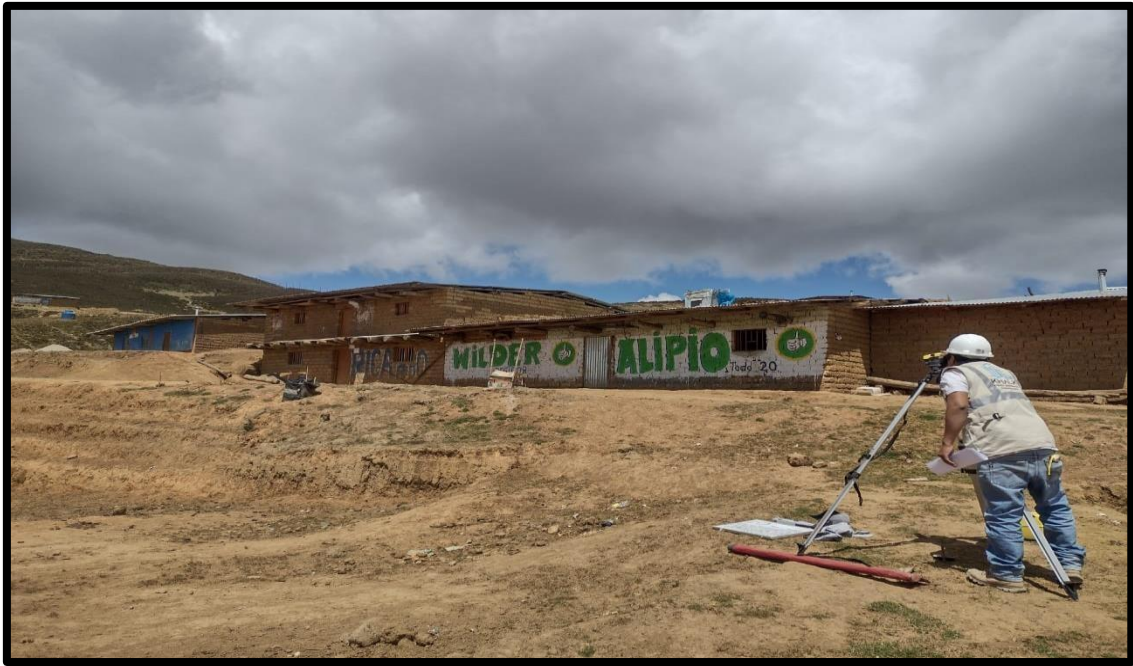
Fotografía N° 05 Cambio de estación
