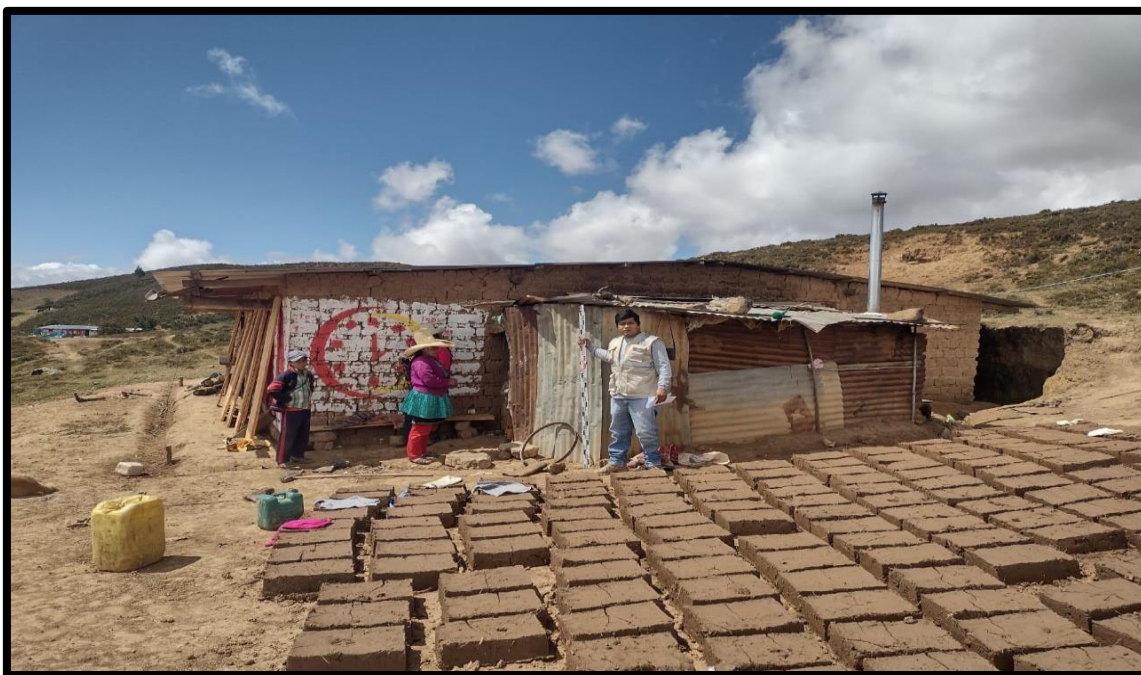
Fotografía N° 07 Ubicación de viviendas.
