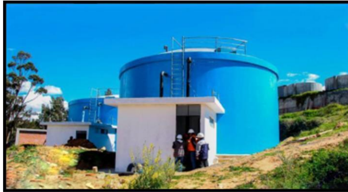
Figura 8: Reservorio de agua potable
