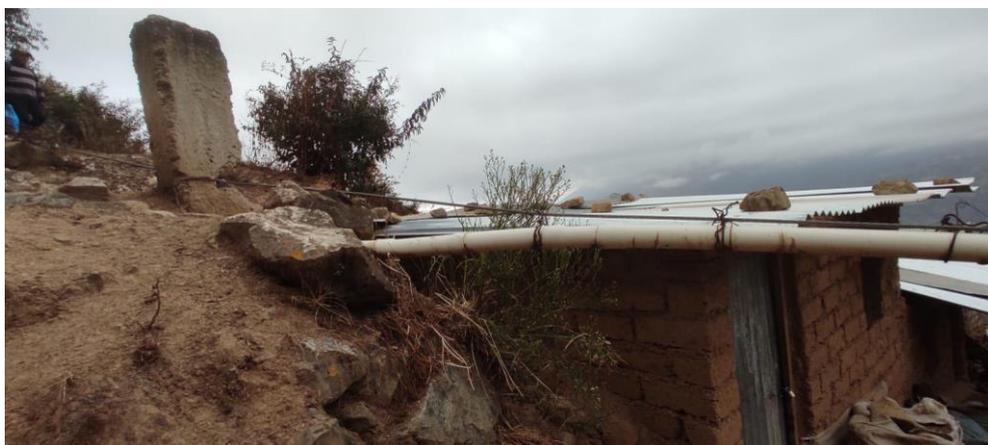
*Imagen 14.* Estructura del pase aéreo de la línea de aducción
