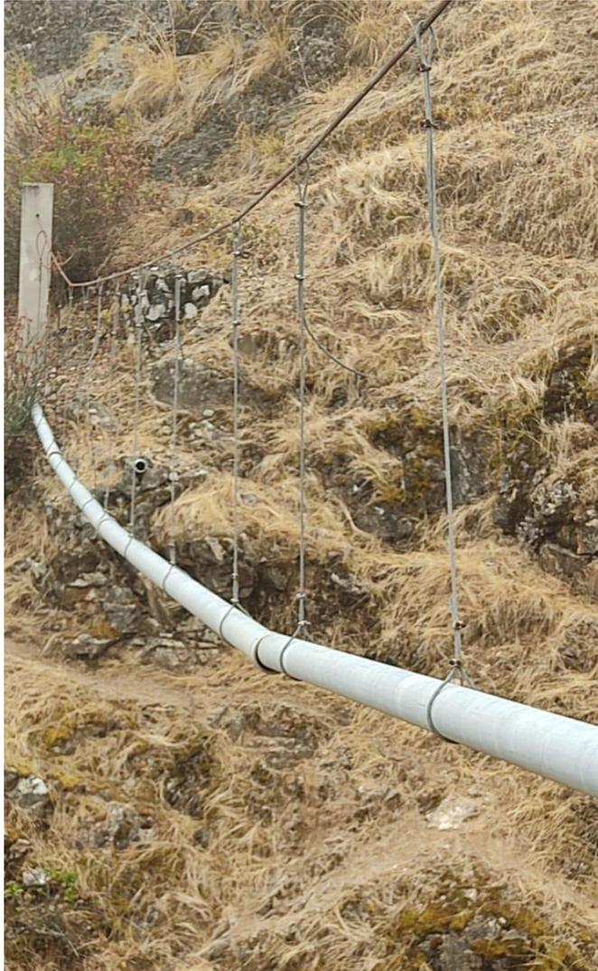
*Imagen 4.* Pase aéreo de la línea de conducción
