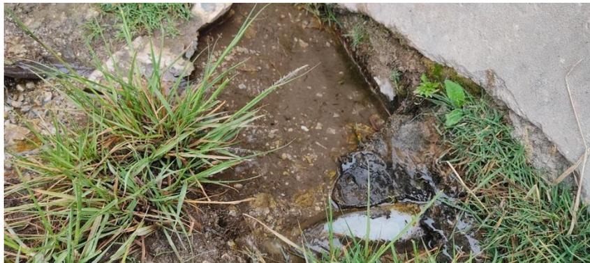
**Imagen 11.** Filtración en la tubería de salida de la cámara rompe presión
