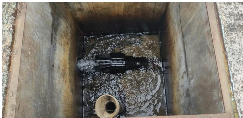
**Imagen 6.** Interior de la cámara rompe presión
