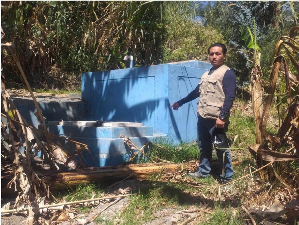
Imagen 03: Captación del sistema de abastecimiento de agua potable del Barrio Allauca, distrito de Caraz, provincia de Huaylas, región Áncash – 2021.
