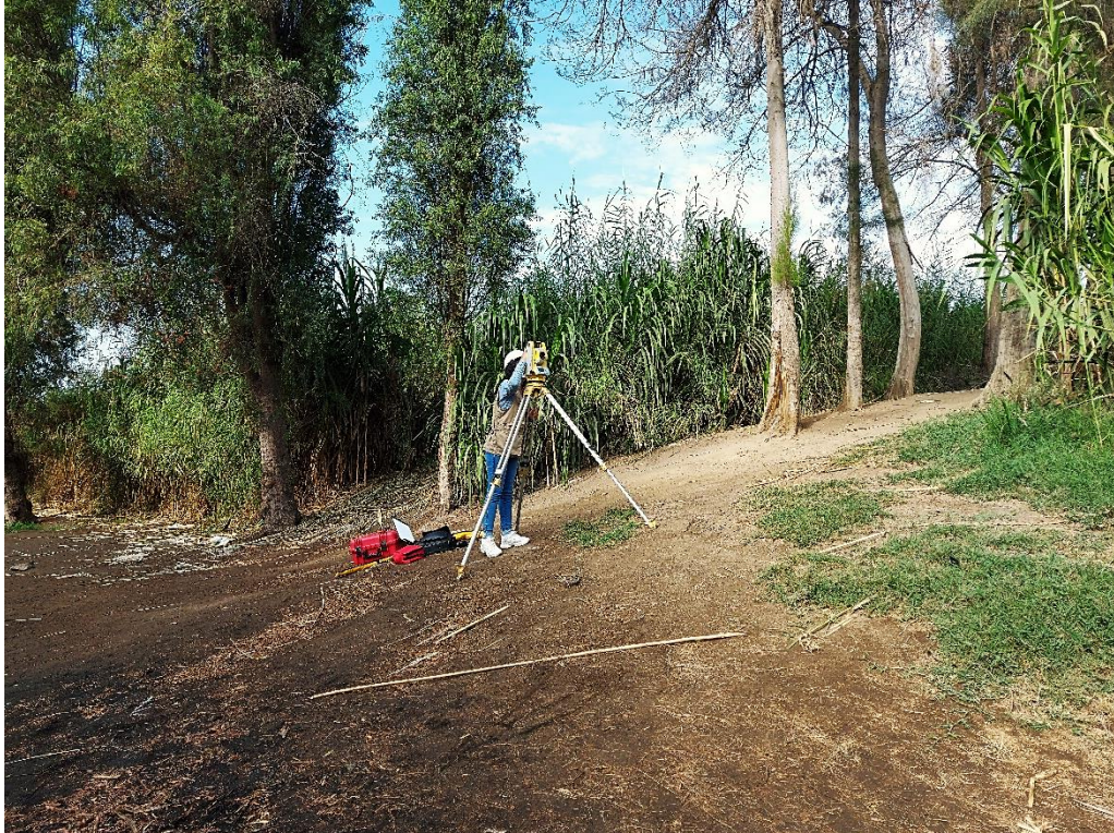
Figura 16: Tomando coordenadas en la zona donde se ubica el manantial de ladera.
