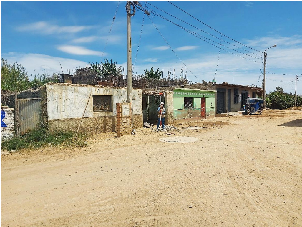
Figura 17: Efectuando el levantamiento topográfico en las calles de Cruz del Siglo.
