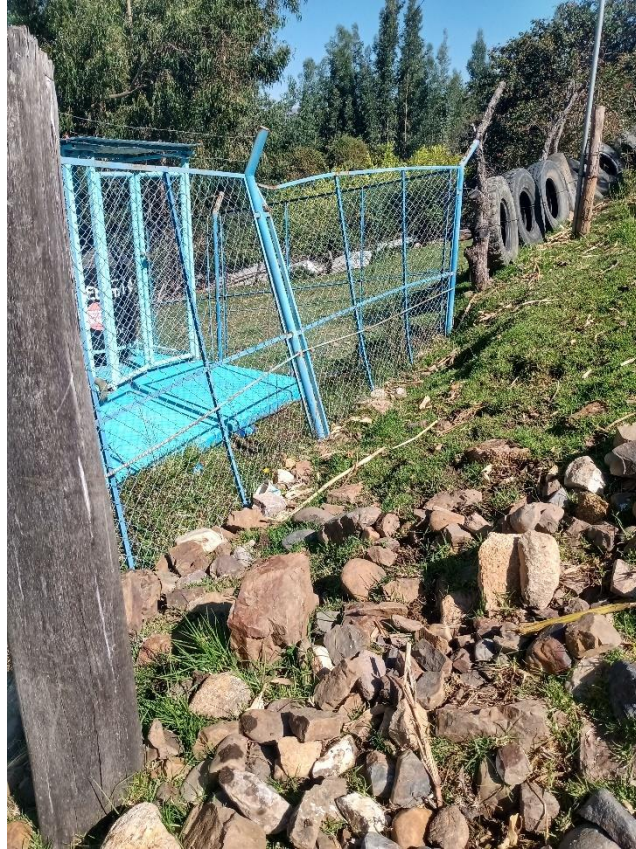
Fotografía 05: Cerco perimétrico del reservorio
