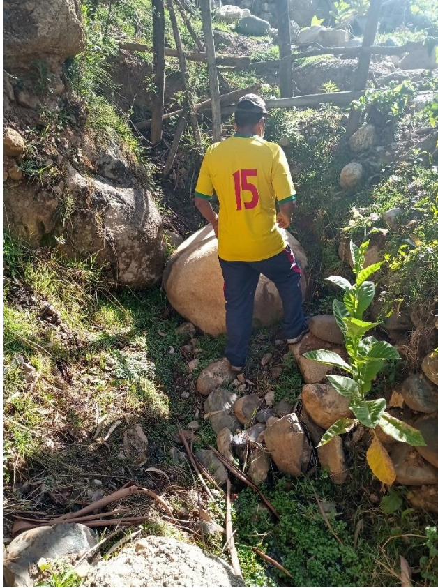
Fotografía 03: Construcción de cerco perimétrico en la captación.
