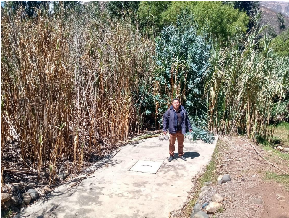
Fotografía 06: Tanque séptico de la PTAR se plantea construir el cerco perimétrico
