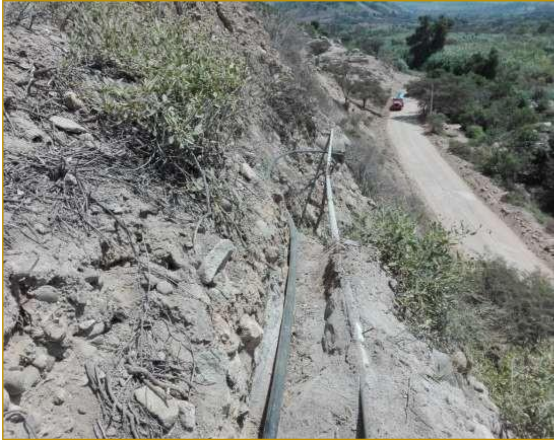
Fotografía 6: Se observa tubería HDP de 2" en la línea de conducción.
