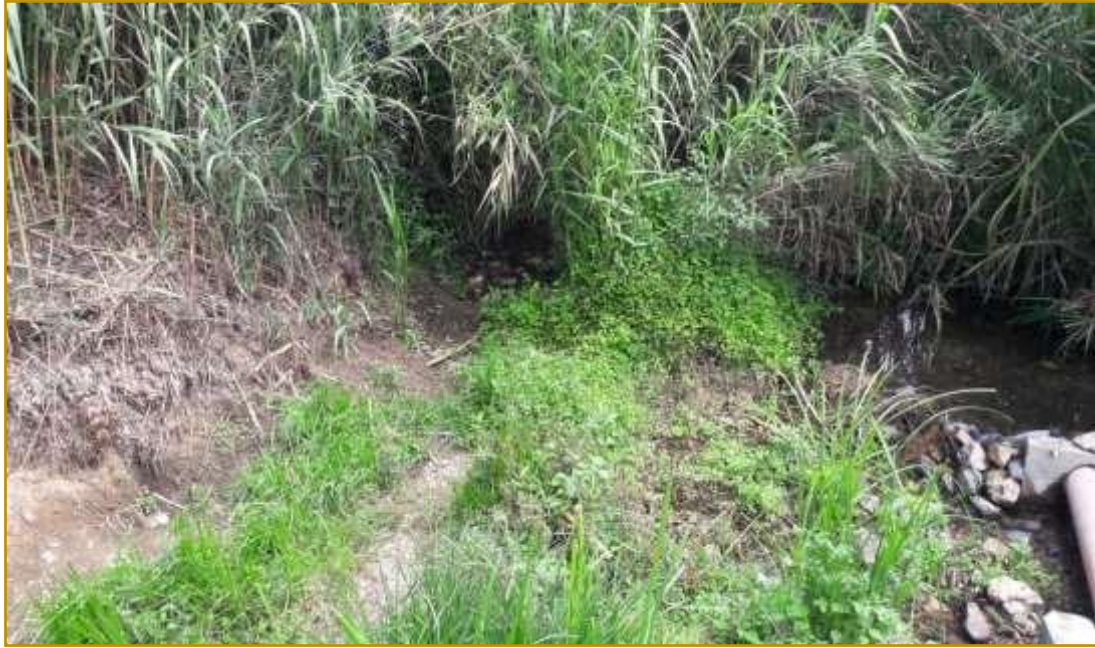
Fotografía 4: Fuente de agua Carrisal.
