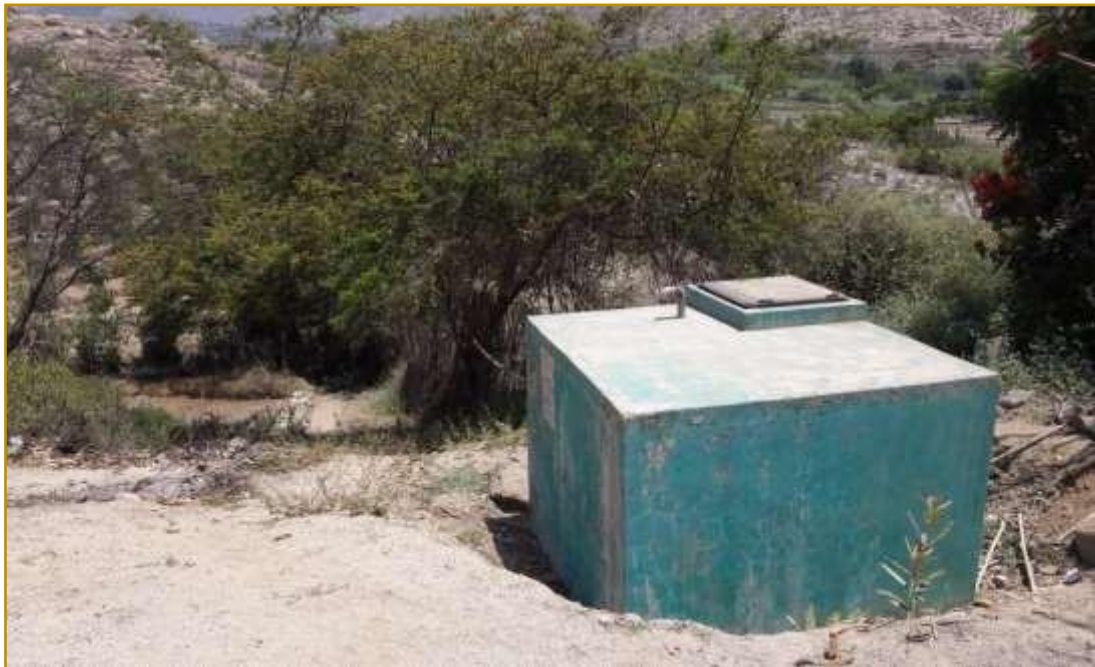
Fotografía 7: Reservorio existente en la localidad de Piedra Grande.
