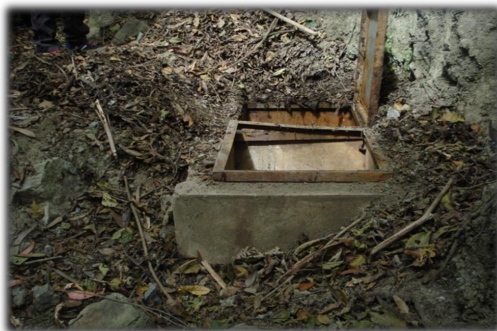
Fotografía 6. Captación Collpa Ruri II
