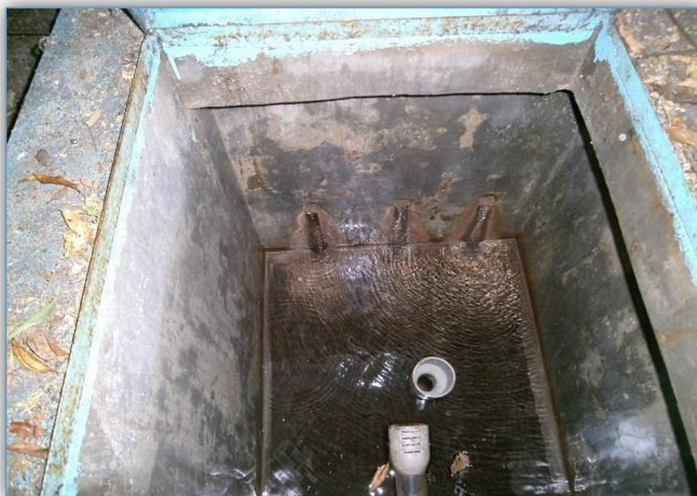
Fotografía 2. Captación Ampec Ruri I
