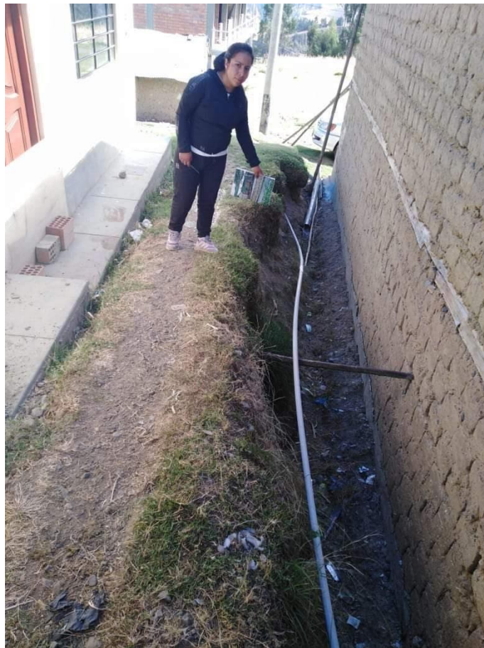
Fotografía 8. Vista de red de distribución descubierta
