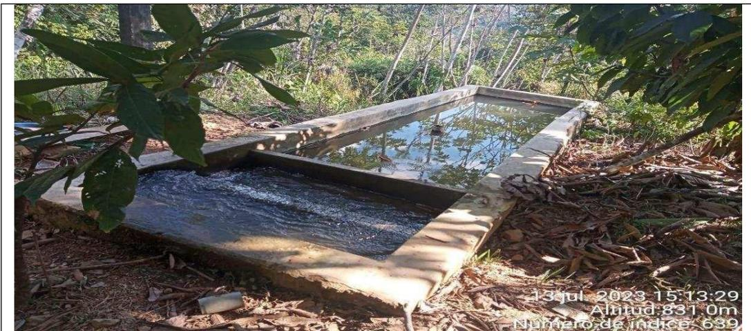
**Figura N° 13** Desarenador, no existe cerco perimétrico.
