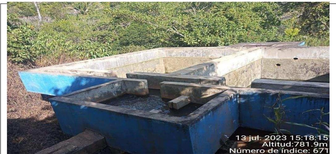
**Figura N° 14** Filtro lento, no existe cerco perimétrico.
