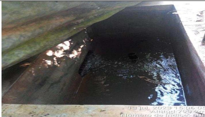
**Figura N° 8** Presencia de patología en la cámara húmeda, no hay canastilla
