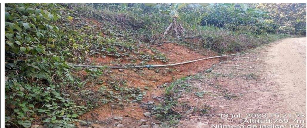
**Figura N° 5** Tubería expuesta a la intemperie 0+720 (D=10m)
