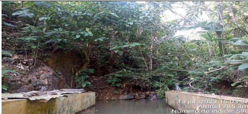
**Figura N° 7** No cuenta con tapa sanitarias en la cámara húmeda.
