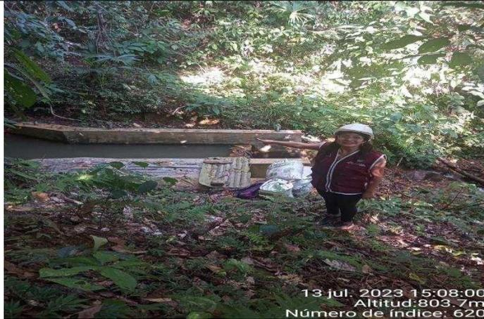
**Figura N° 6** No existe cerco perimétrico en la captación tipo barraje
