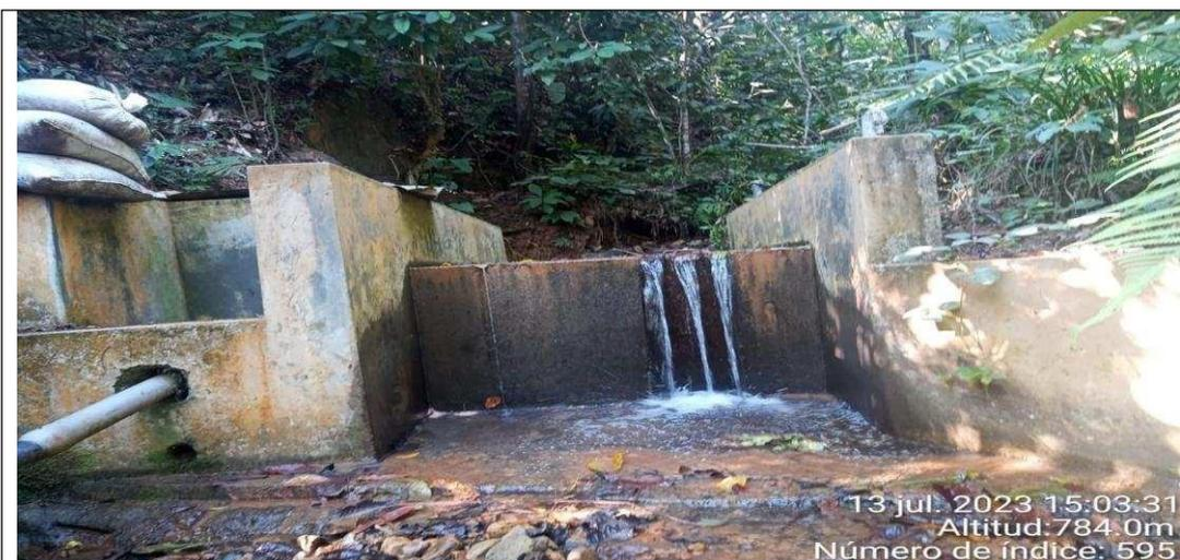
**Figura N° 12** Captación tipo barrage
