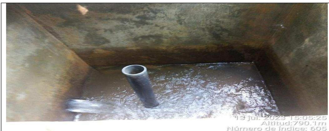
**Figura N° 9** No se evidencia canastilla
