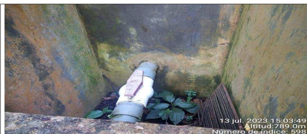
**Figura N° 11** Válvula deteriorada por el tiempo de uso, expuesta a la intemperie.
