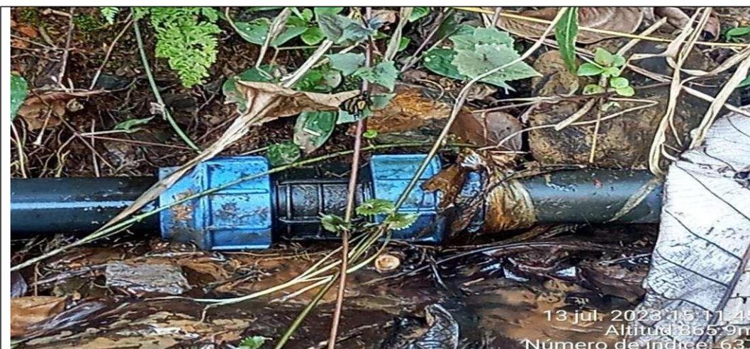
**Figura N° 4** Reparación de un empalme empíricamente con bolsas de plástico 0+060
