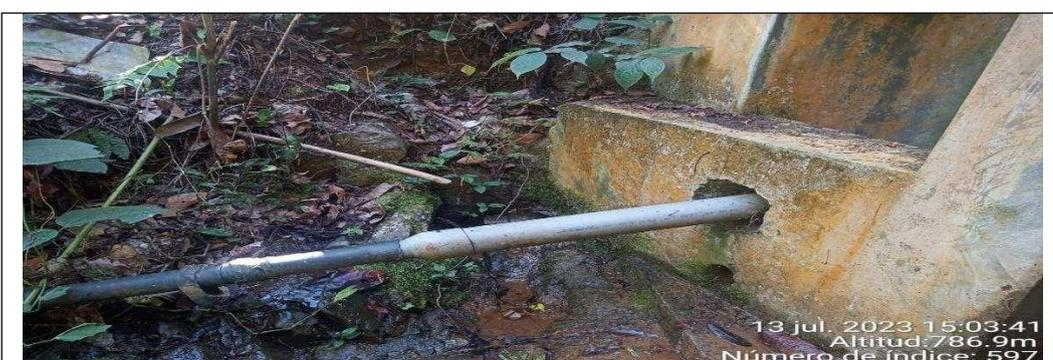
**Figura N° 10** Precario empalme de tuberías.
