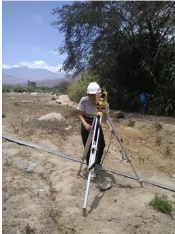
Figura 18. Realizando el levantamiento topográfico de la línea de conducción.
