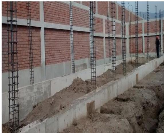
*Figura 9:* Detalle de sobre cimiento - Fuente: Blogspot Guarda construcciones.
