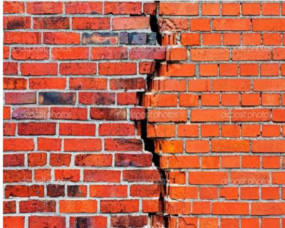
*Figura 12:* Grietas en muros – Fuente: Revista oyp.com.articulo 7-2017
