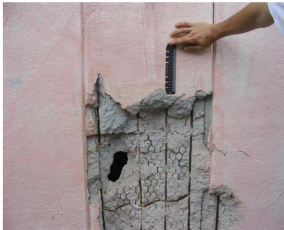
*Figura 13:* Desintegración en el concreto en una columna – Fuente: Castillo S, André C, Falcón C, Felpe L. 2015<sup>28</sup>
