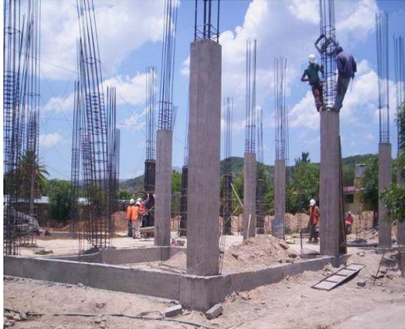
*Figura 6:* Columna de concreto armado - Fuente: Pagina de Arquys.com
