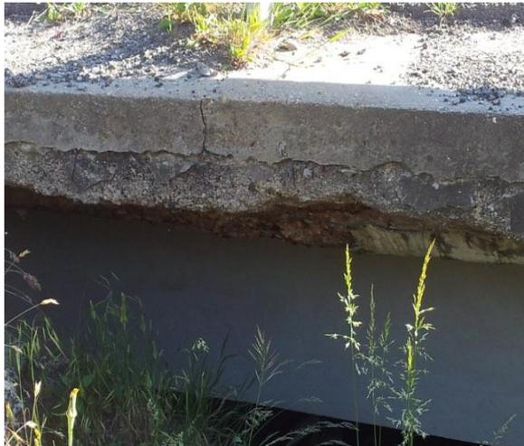
*Figura 11:* Disgregamiento en muro – Fuente: Elaboración propia 2017
