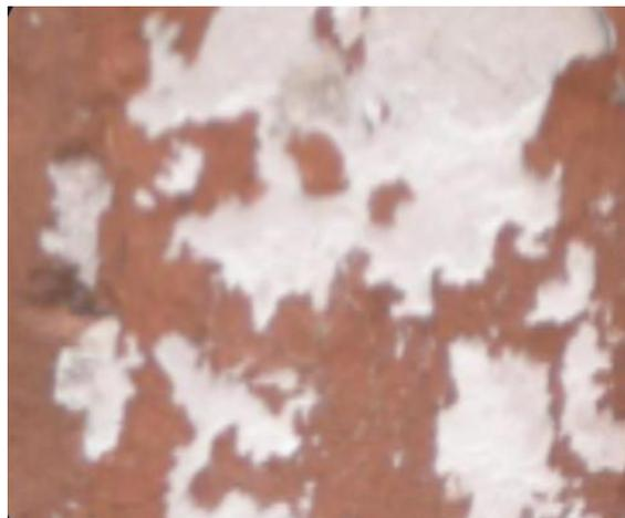
*Figura 15:* Descascaramiento en muro – Fuente: Quezada E. 2004<sup>30</sup>
