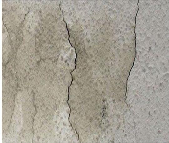
**Figura 10:** Fisuras en muros - Fuente: Astorga A, Rivero P. 2009<sup>23</sup>
