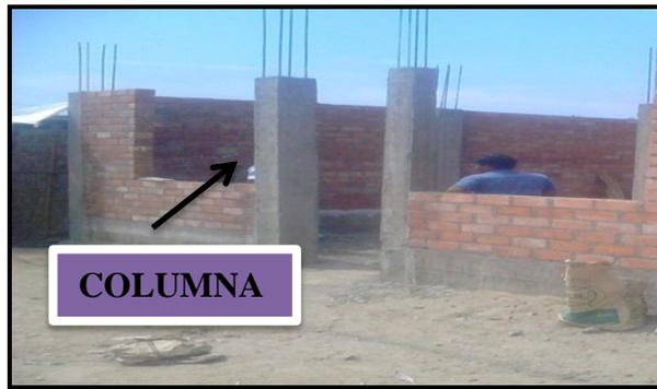
**Figura 9: Columnas estructurales**
