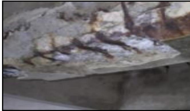
**Figura 16: Deterioro por corrosión en el acero.**
