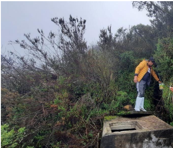
AFORO DE AGUA INGRESANTE A LA CAPTACION
