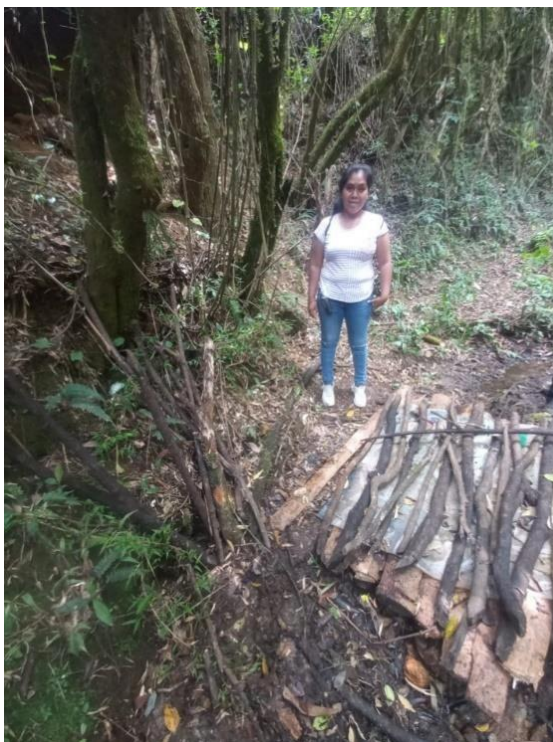
Vista a la captación del sistema de abastecimiento de agua potable
