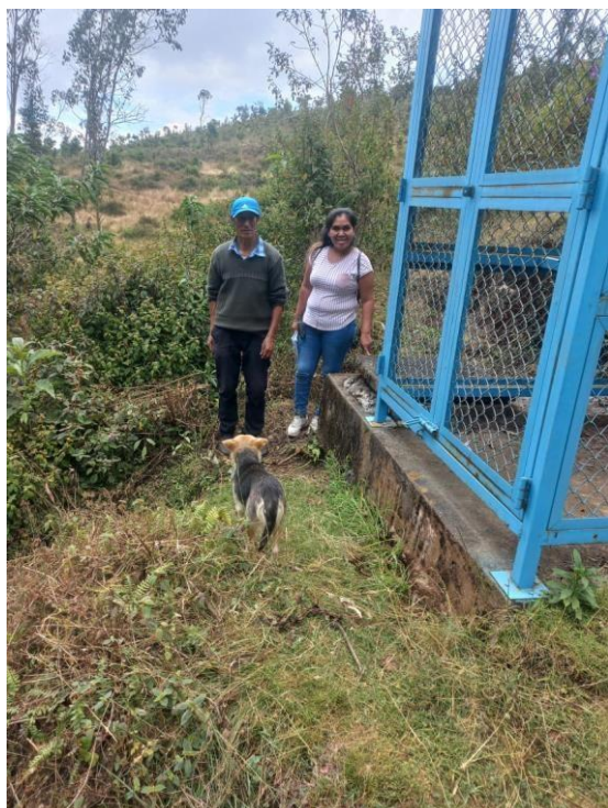
Vista al reservorio del sistema de abastecimiento de agua potable
