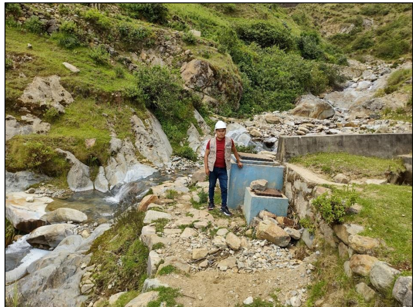
Imagen 02. Zona de la estructura de la captación
