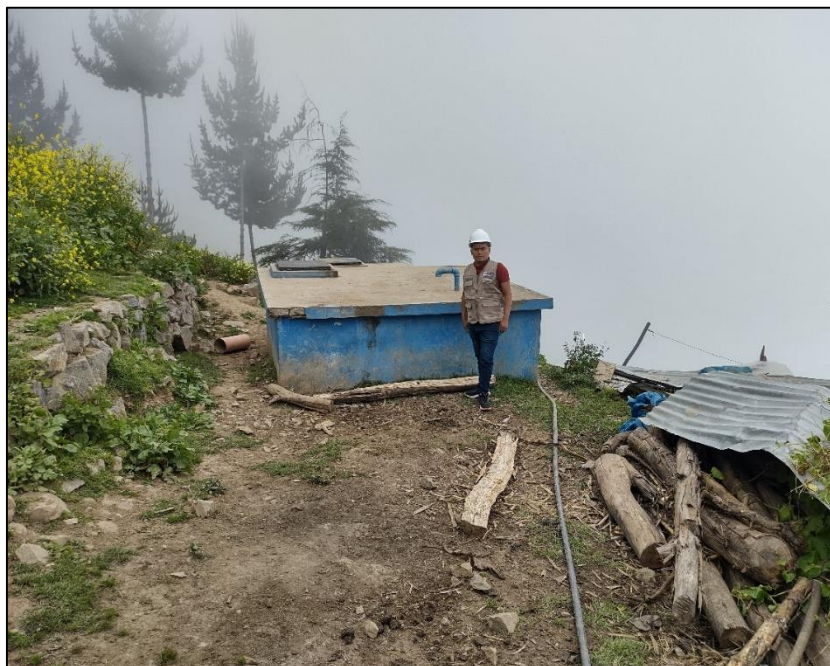
Imagen 06. Zona estructural del reservorio
