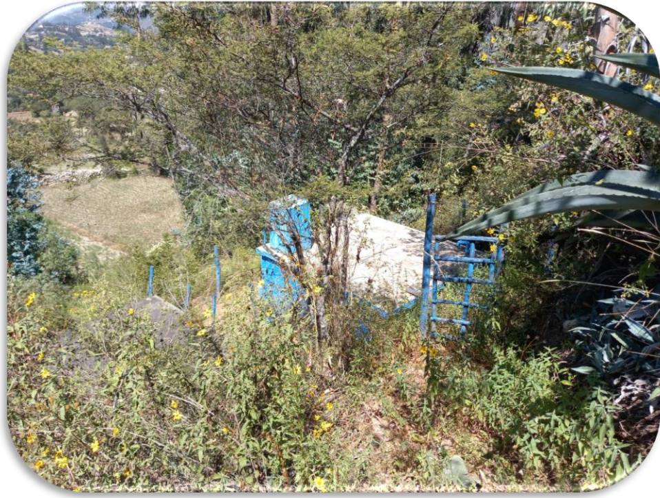
Vista de estructura de reservorio.
