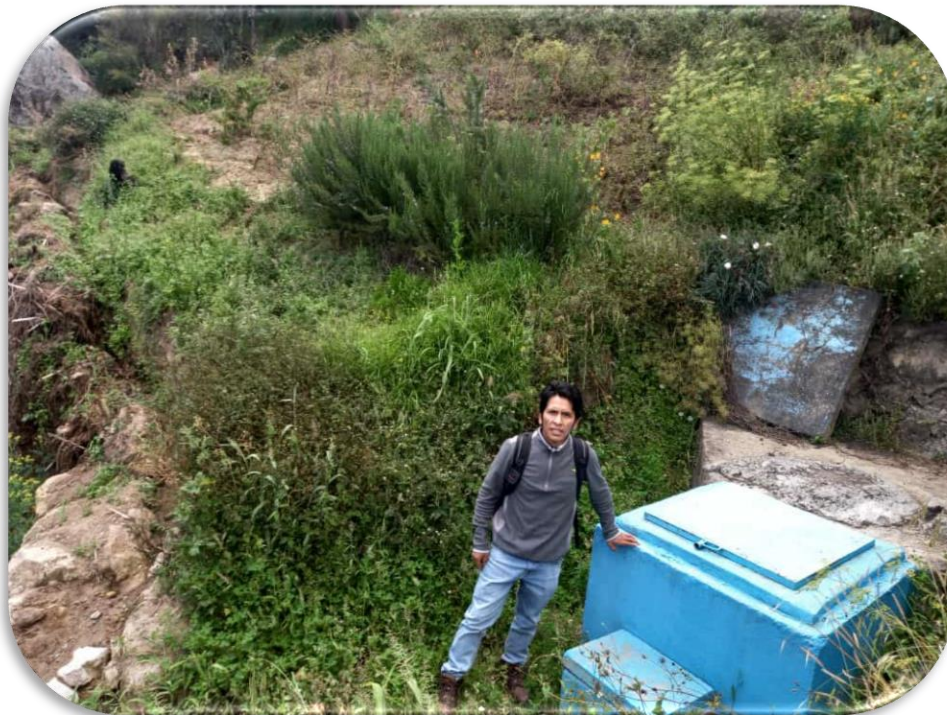
Vista de captación subterránea Lapitoc.
