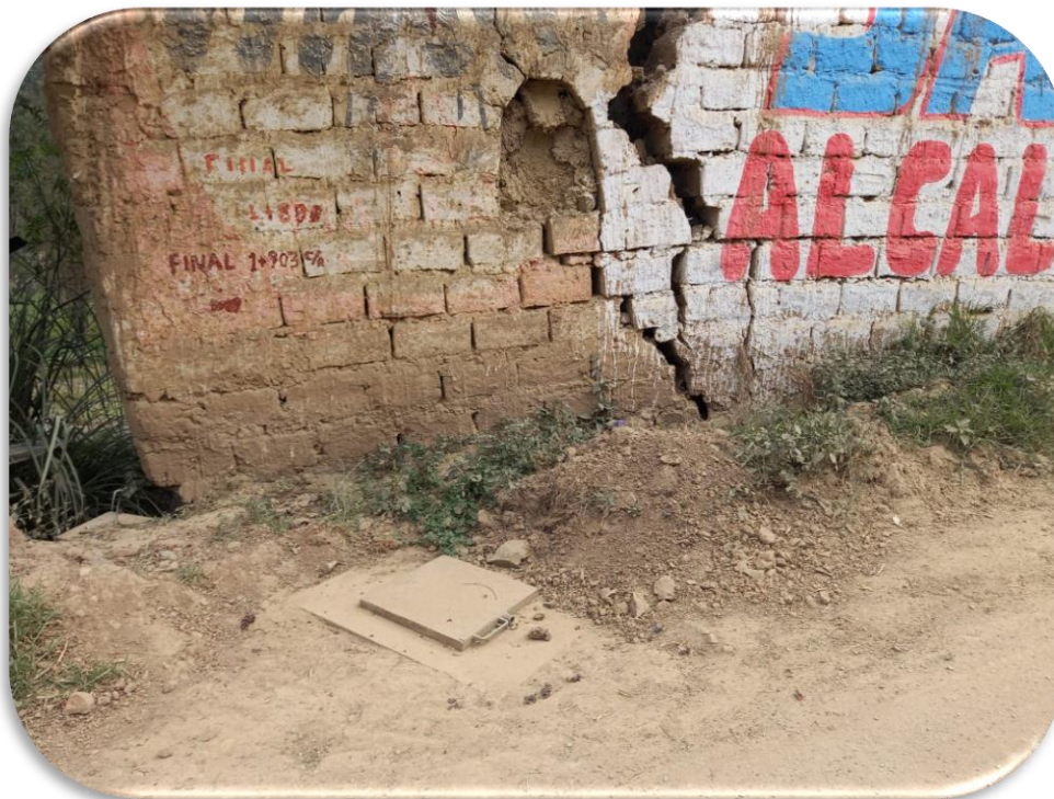
Vista de caja de purga y limpieza 02.
