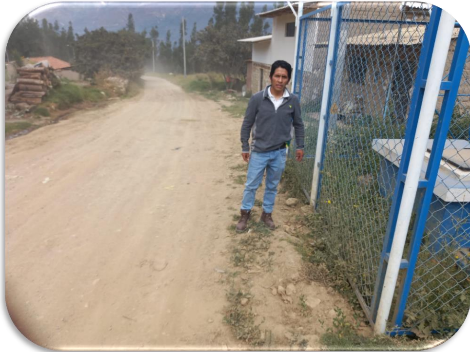
Vista de caja rompe presión.
