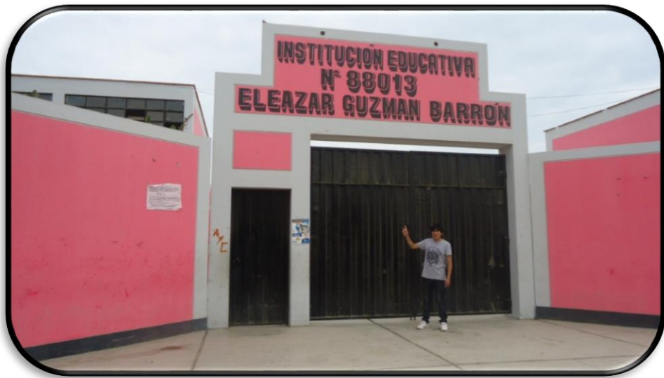
Fotografía 01: Vista Panorámica de la I.E. Eleazar Guzmán Barrón N° 88013 ubicado en el P.J. La Victoria distrito de Chimbote, provincia del Santa, departamento de Ancash – Enero 2015.
