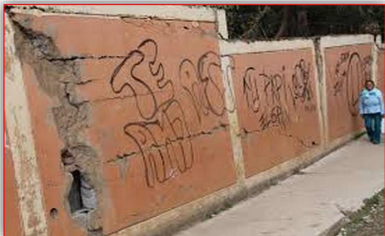
Imagen N° 01: Cerco perimétrico colegio Cristo rey
