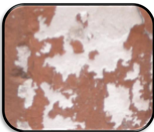
Imagen 19: Tipo de Patologías / Descascaramiento
