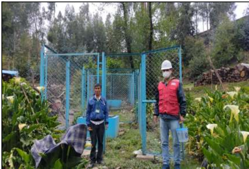
Figura 43: Vista de la captación 2, se observa el cerco perimétrico.
