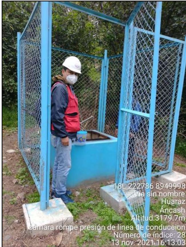
Figura 46: Vista de la segunda CRP 6, se observa cerco perimétrico.
