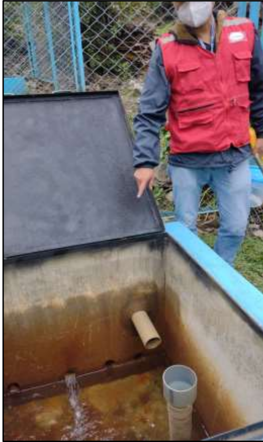
Figura 44: Vista de la cámara húmeda de la captación 2.
