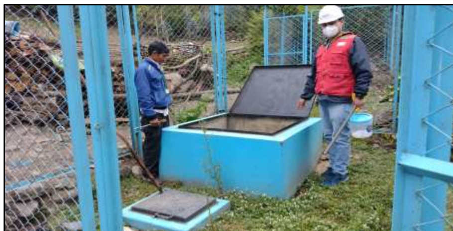
Figura 18: Vista de la captación 1 y 2, ambos cuentan con cerco perimétrico
