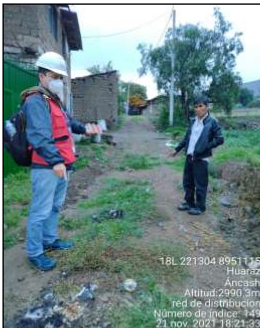
Figura 59: Vista de la red de distribución y las conexiones domiciliarias.
