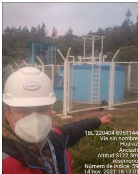
Figura 51: Vista del reservorio de 35 m 3 , se observa cerco perimétrico.
