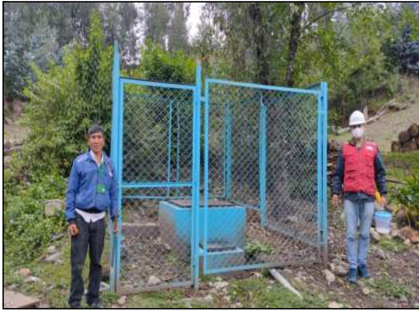
Figura 38: Vista de la captación 1, cuenta con cerco perimétrico
