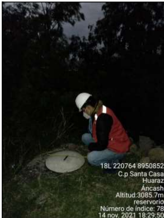
Figura 55: Vista de la válvula de aire, se observa que no tiene gancho en la tapa.
