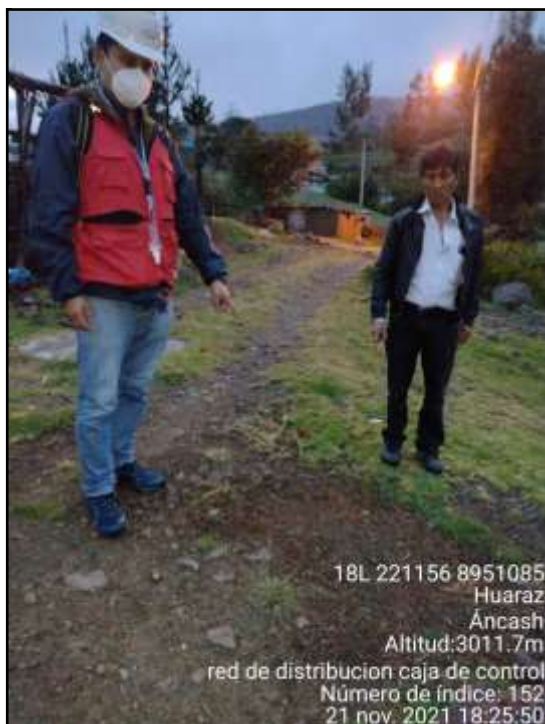
Figura 61: Vista de la caja de válvula de control, no se nota porque está enterrado.
