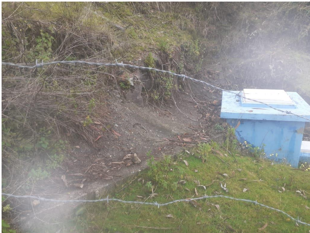
Fotografía N° 02: Tercera Captación - Zona Yulapyacu
