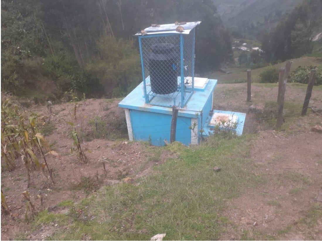
Fotografía N° 05: Reservorios de almacenamiento
