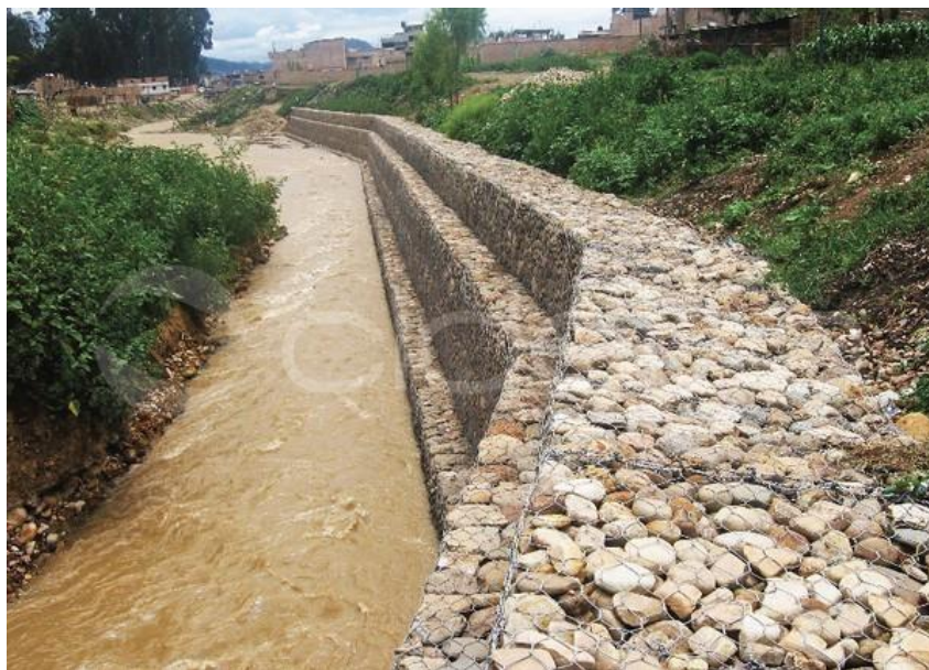
Gráfico N° 14. Sistema de defensa ribereña co gaviones Perené
