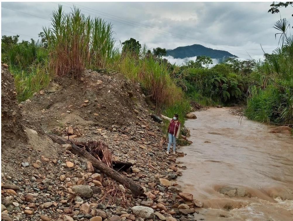
Defensa ribereña realizada por los propios pobladores
