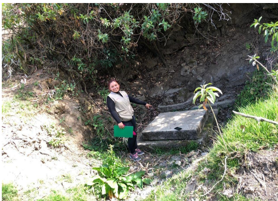
Imagen 2: Cámara de captación de la localidad de Huayán, Distrito de Huayán, Provincia de Huarmey, Departamento de Ancash-2019.
