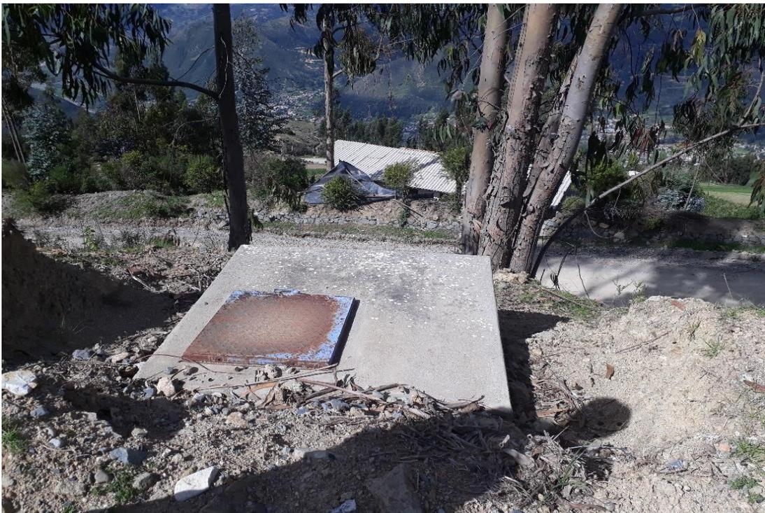
**Fotografía 14. Cámara de rompe presión Tipo 7 – CRP7**
