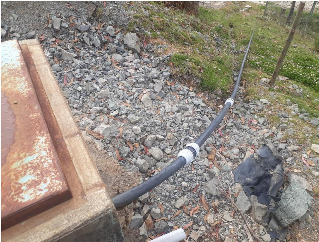
**Fotografía 09. Tubería que conduce agua de EPS Chavín al PTAP**
