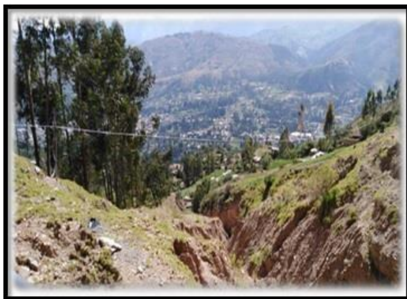
Figura 04: Línea de conducción, pase aéreo.
