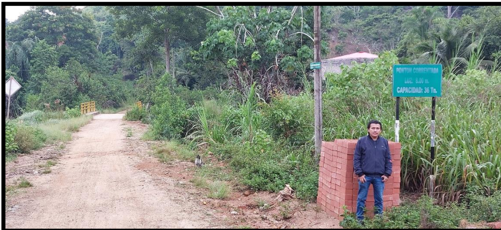
Grafico 15: Pontón del Centro poblado de correntada Fuente: Evidencia de campo, 2023.
