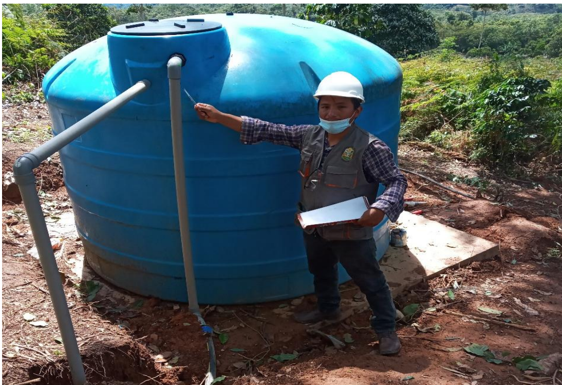
Foto 9: Se aprecia el reservorio de 5000 Litros pre fabricado que cuenta con la salida de reboce e ingreso de agua, pero no cuenta con caseta de válvulas.
