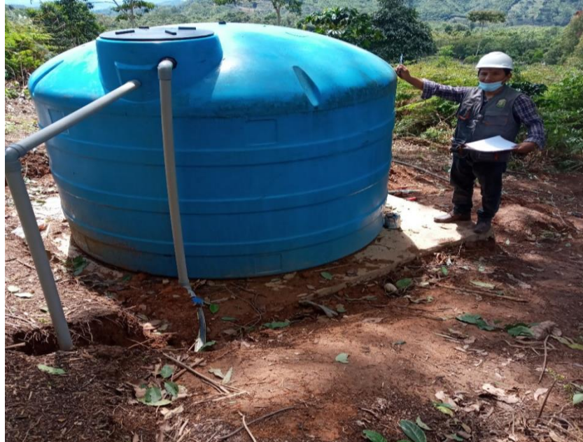
Imagen 5. Se aprecia el reservorio existente de 5000 lts.
