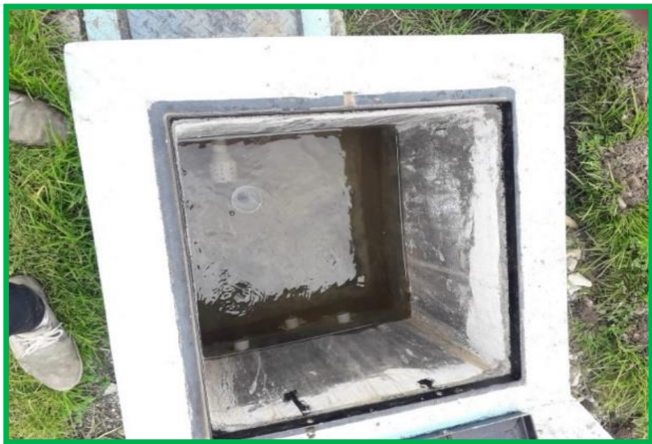
Fotografía 04: Verificación de la cámara húmeda
