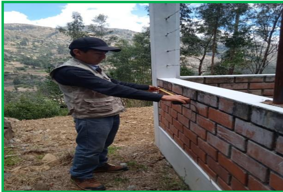
Fotografía 06: cerco perimétrico del reservorio
