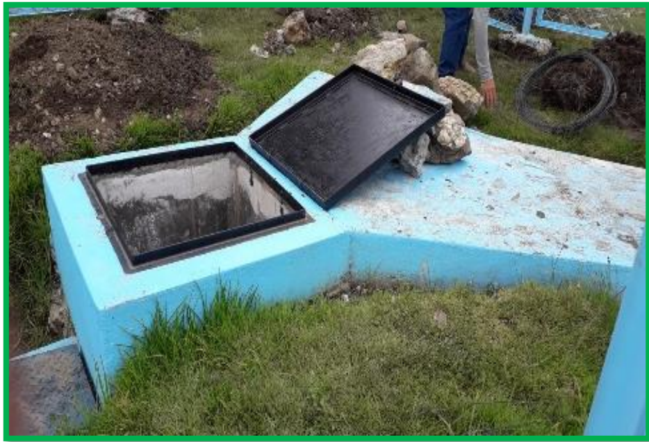
Fotografía 03: Verificación de la cámara húmeda
