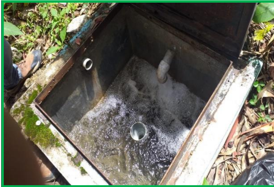
Fotografía 05: Observación del estado de la cámara rompe presión
