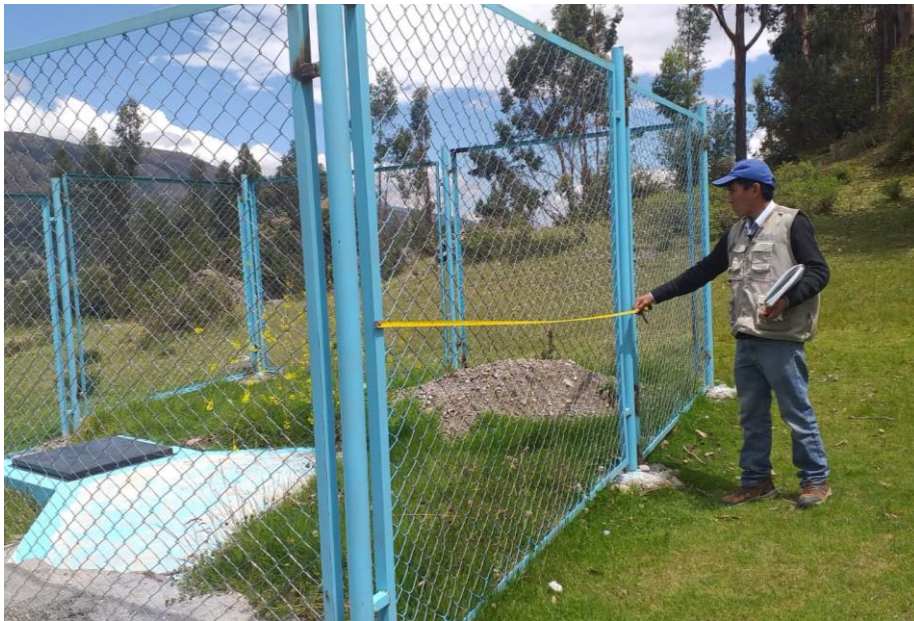
Fotografía 02: verificación de medidas del cerco perimétrico de la captación.
