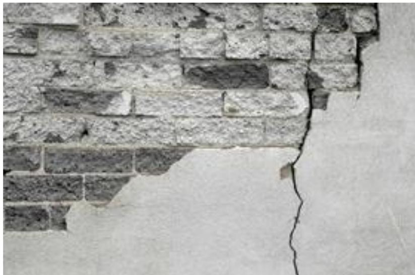
*Figura 7.* Grietas en muro de albañilería
