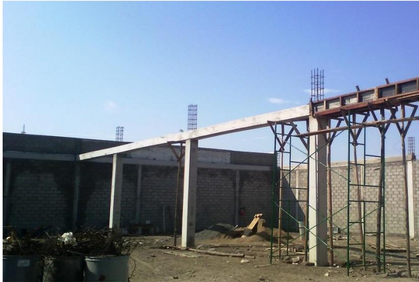
*Figura 2. Columnas y vigas de concreto armado.*
