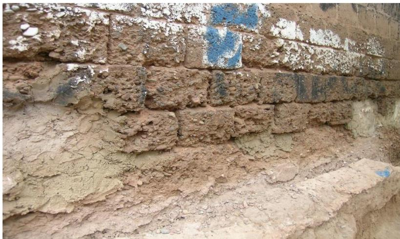
*Figura 6. Erosión de muro de albañilería.*
