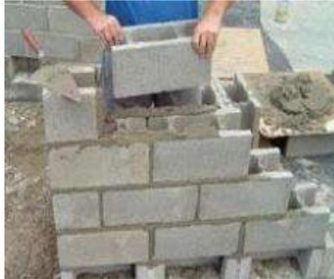
*Imagen 2.* Colocación de ladrillos para muro con concreto simple
