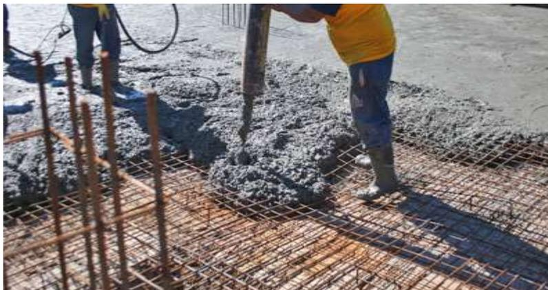
*Imagen 3.* Vaciado de una losa de concreto armado
