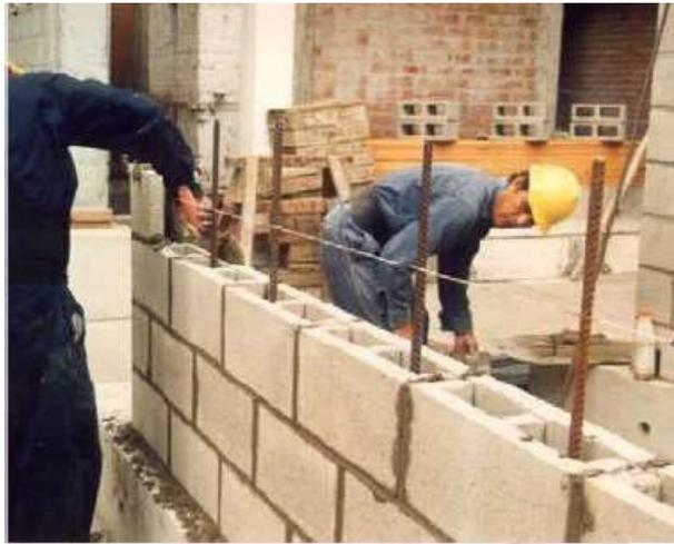
*Imagen 5. Albañilería armada*
