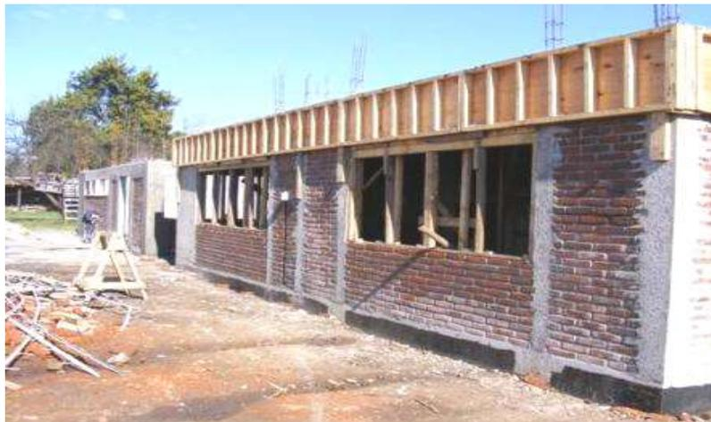
*Imagen 4.* Albañilería confinada con sus elementos
