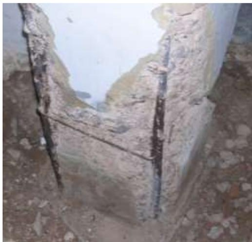
*Imagen 18. Corrosión en columna*
