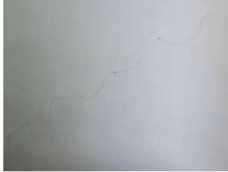
*Imagen 15. Fisura en muro*
