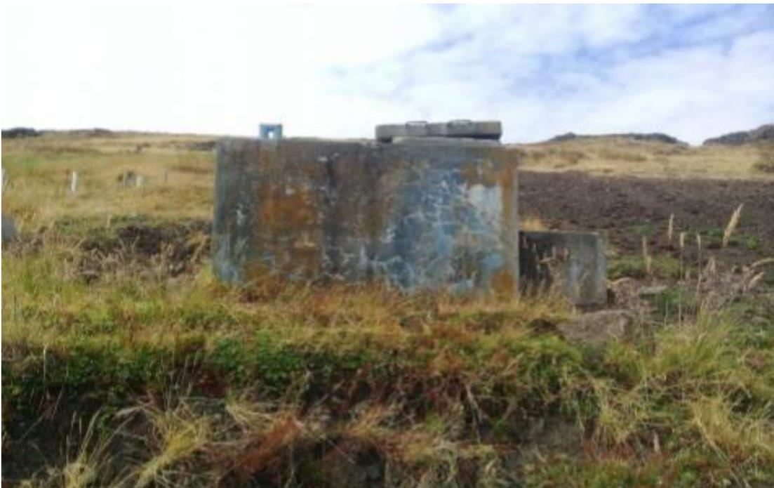
**FOTO 05:** Se observa el reservorio totalmente deteriorado, la estructura agrietada, aceros expuestos por el pasar de los años.
