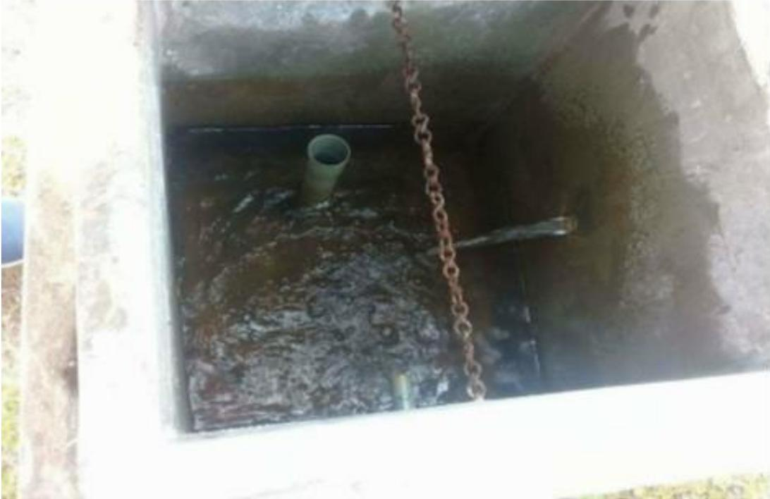
**FOTO 04:** Se observa la cámara de captación honguizada y la estructura exteriormente con eflorescencia.
