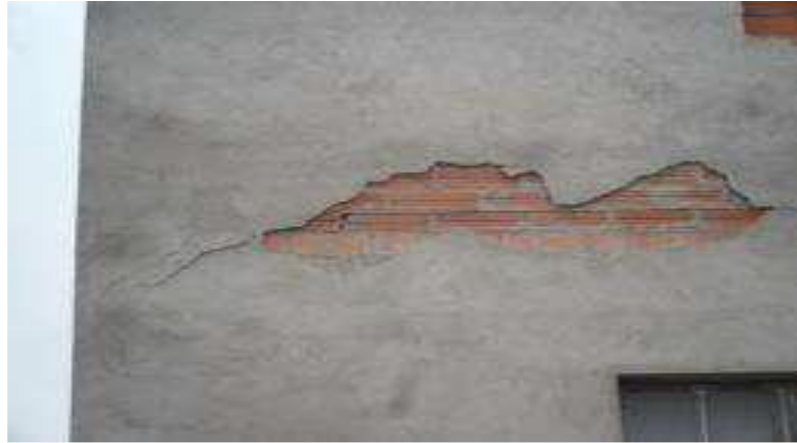
Figura 13: imagen de desintegración
